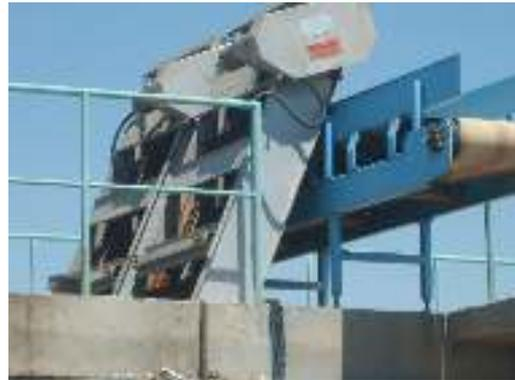
Figure V.1: le dégrillage
