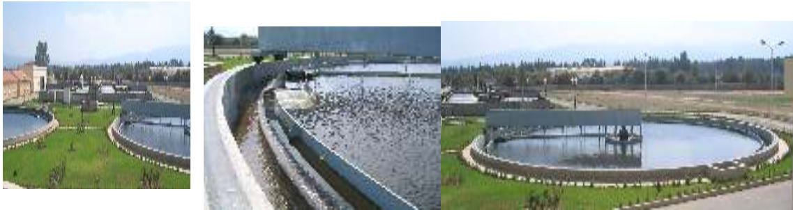
Photo 10 : Décanteurs secondaires de la STEP de la ville de Hadjout
