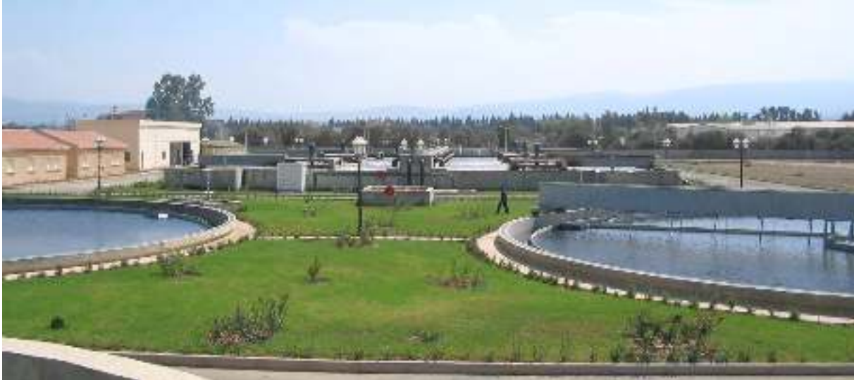
Photo 1 : Station d'épuration des eaux usées de la ville de Hadjout
