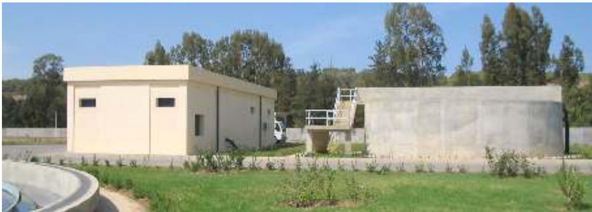
Photo 13 : Déshydratation par presse à bandes (à gauche) ; Epaisseur de boues (à droite) de la STEP de la ville de Hadjout
