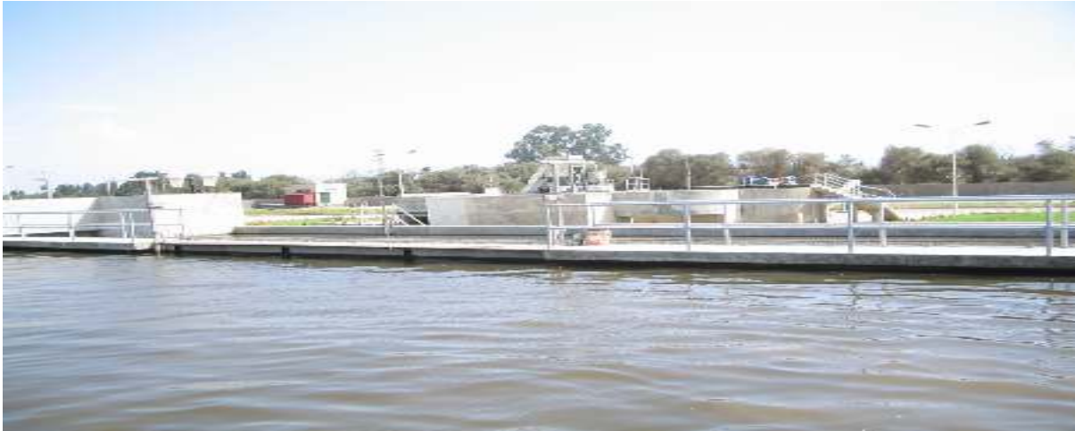
Photo 8 : Compartiment Anoxique - Traitement biologique - de la STEP de la ville de Hadjout
