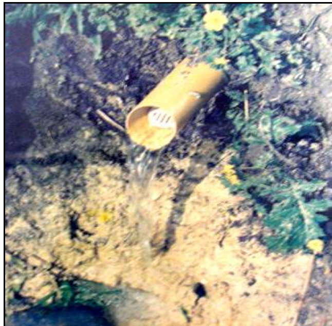
Figure II.3 : Sortie de drain enterré et son diamètre
