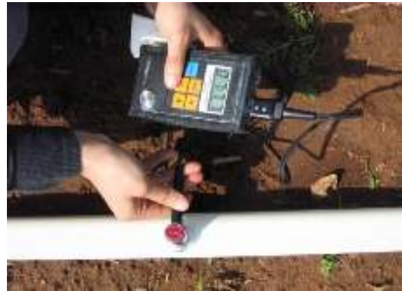
Figure III.18 : positionner la sonde sur la conduite d'une façon parallèle
