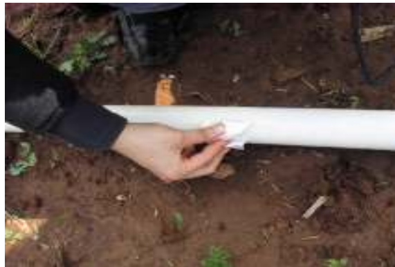
Figure III.5 : Nettoyage de la conduite
