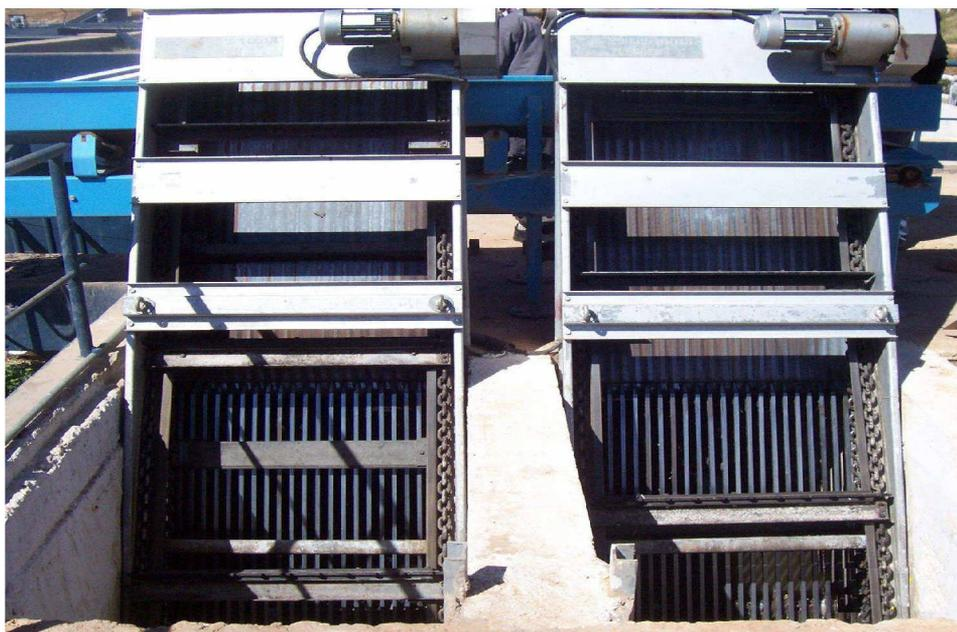
**Photo III.3 :** Grilles mécanisées fine de la STEP de la ville de Tlemcen
