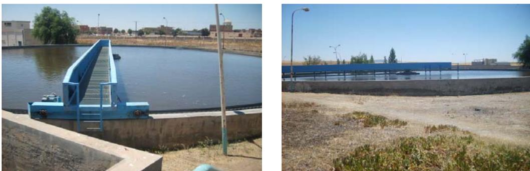
**Figure V.5 :** le décanteur secondaire
