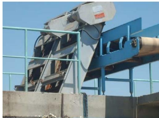
Figure V.1: le dégrillage
