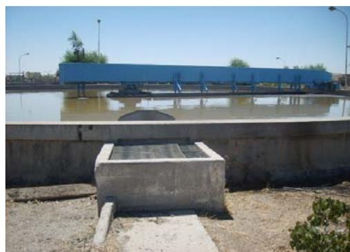
Figure V.3 : le décanteur primaire
