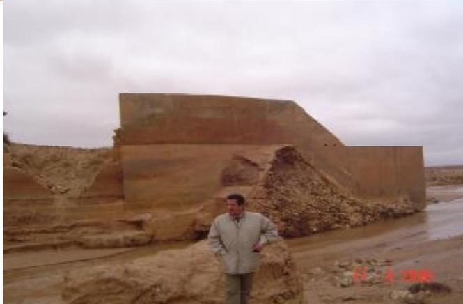
Vue sur le corps de l'ancien ouvrage exécuté en gabions et protection en béton •
