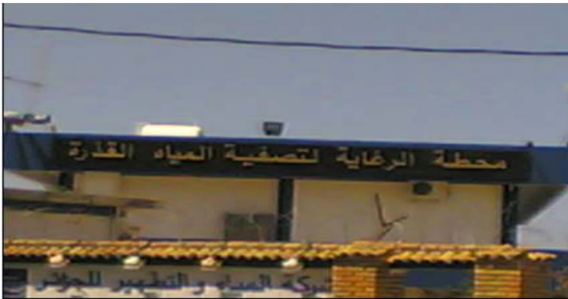
FigV-2: station d'épuration des eaux usées de la ville de Réghaia
