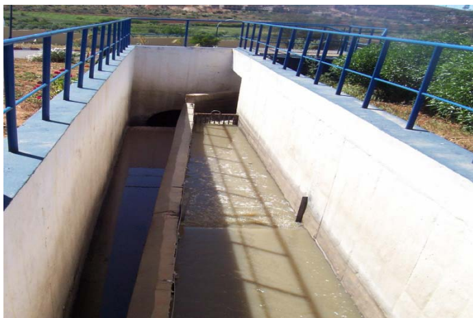
Figure IV-1 : Déversoir d'orage de la STEP de la ville de B.B.A
