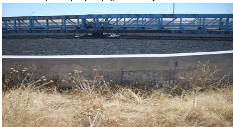
Figure IV.7 : L'épaississeur de la STEP de la ville de B.B.A
