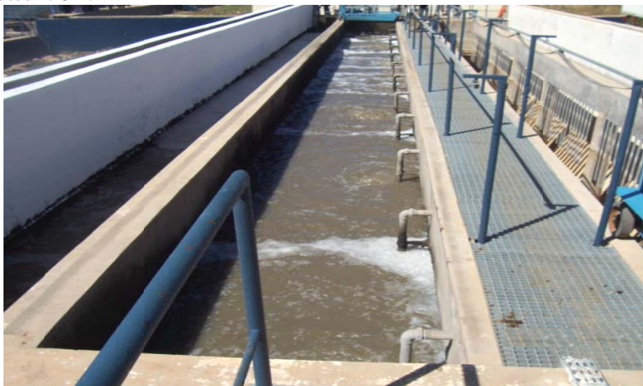
Figure IV-3 : Dessableurs-déshuileur de la STEP de la ville de B.B.A
