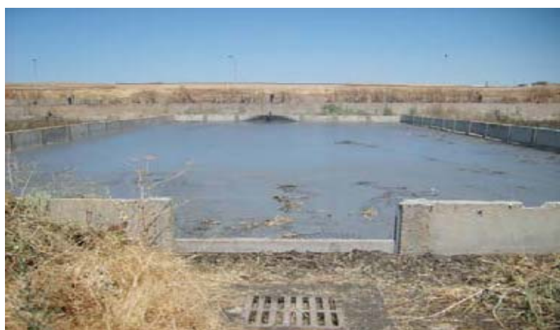
Figure IV.8 : Lit de séchage de la STEP de la ville de B.B.A
