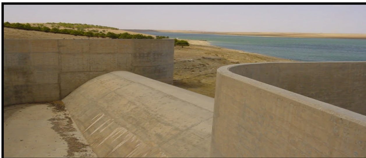
Figure II.2.1.1.a-3 : Evacuateur de crue.
