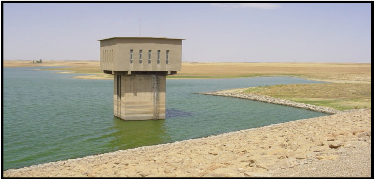
Figure II.2.1.1 : Barrage de Dahmouni et sa tour de prise (Oct. 03).
