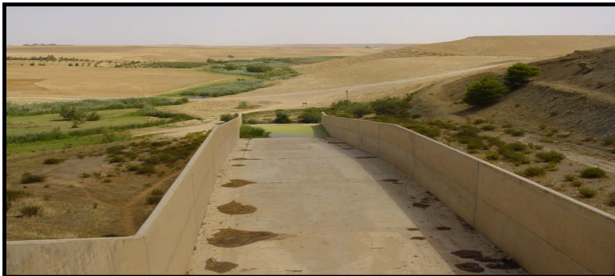
Figure II.2.1.1.a-3 : Evacuateur de crue.
