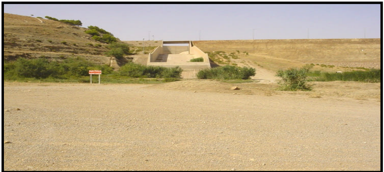
Figure II.2.1.1.a-2 : Partie aval du barrage.
