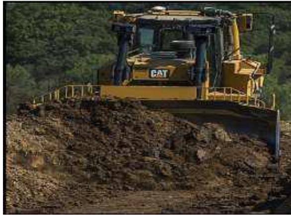
**Figure VIII.2 :** Décapage par bulldozer
