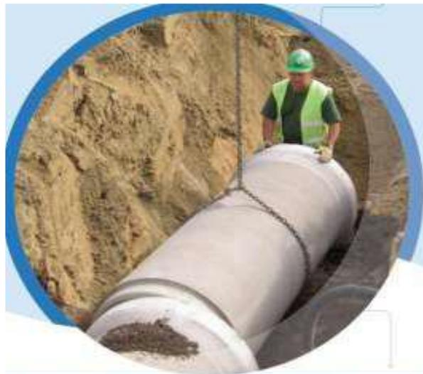
**Figure VIII.3 :** Mise en place des canalisations.
