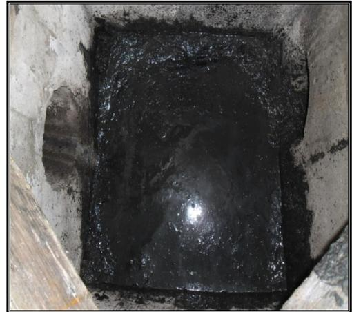
**Figure II.2:** Dépôts sur le radier (sables, résidus de béton)
