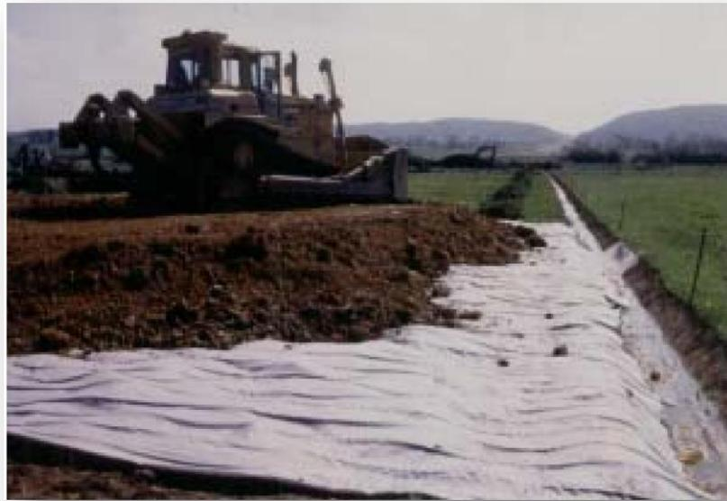
**Photo (3): Mise en œuvre du géocomposite SOMTUBE FTF**
