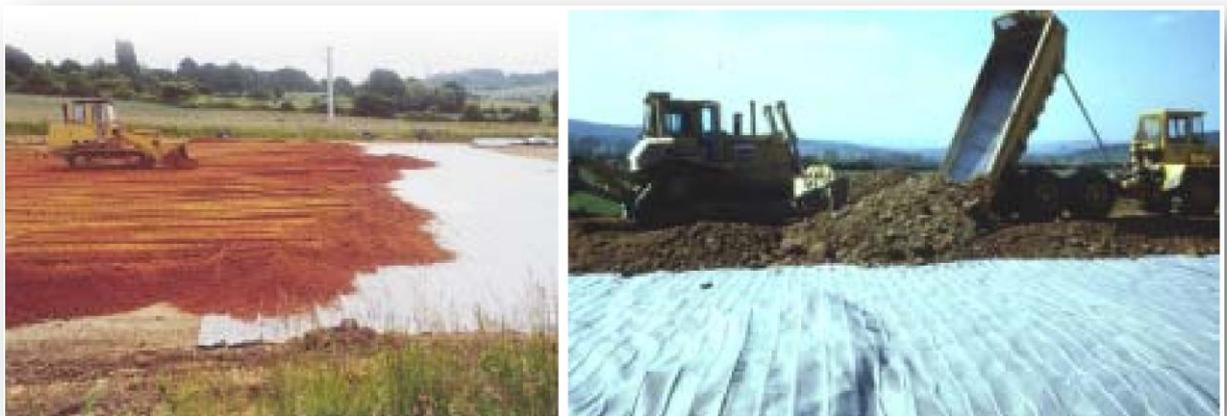
**Photos 9 & 10: Remblaiement à l'avancement**
