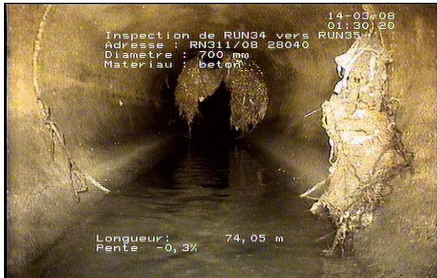
**Photo (5) : Système racinaire pénétrant dans une conduite d'assainissement**
