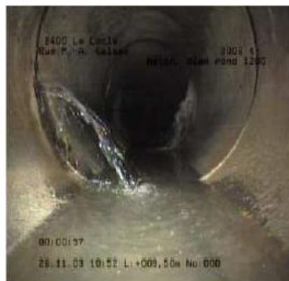
**Photo (4) : Infiltration d'eau claire parasite permanente (ECPP) dans un réseau d'assainissement.**
