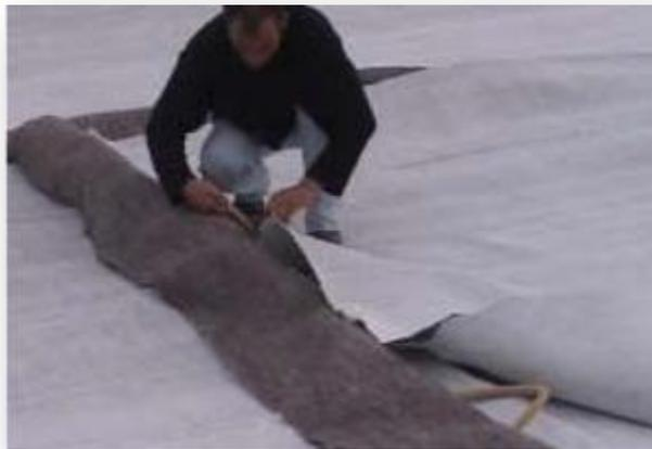
**Photo 6: Traitement des joints transversaux (bout à bout)**
