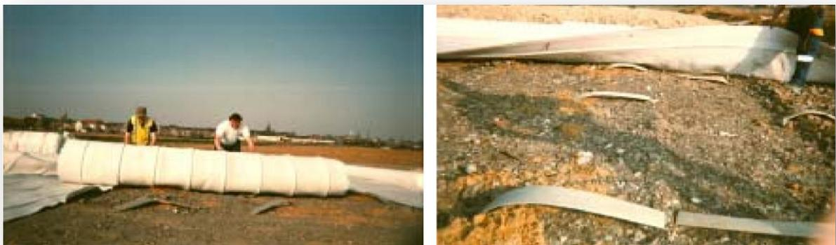
**Photos 4& 5 : Connexion hydraulique SOMTUBE FTF – drains verticaux**
