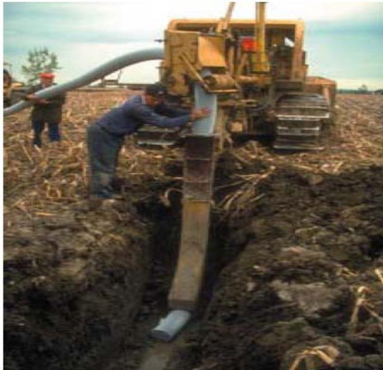
**Fig.44: photo d'une machine draineuse**
