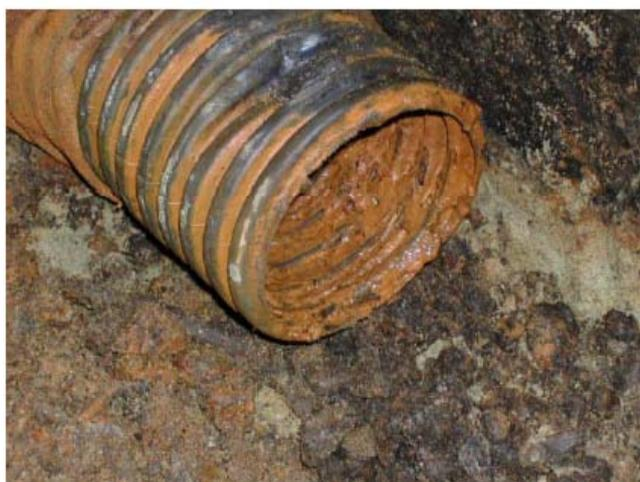
**Fig.47:Colmatage ferrique des orifices d'un drain**
