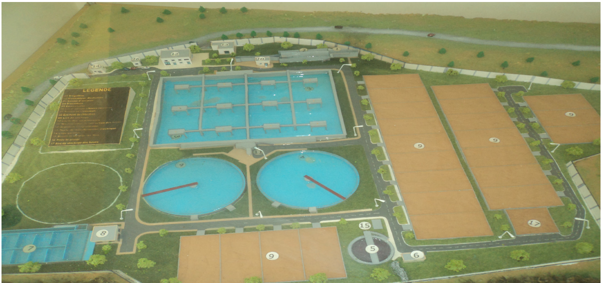
Photo III.1 : station d'épuration de la ville de Médéa
