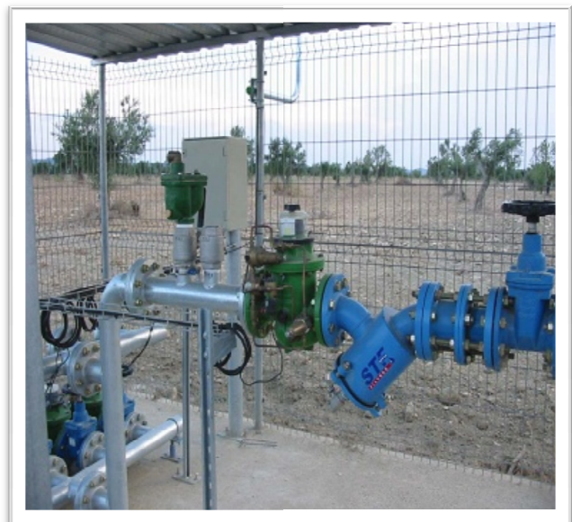
Photos .3.V. bornes d'irrigation.
