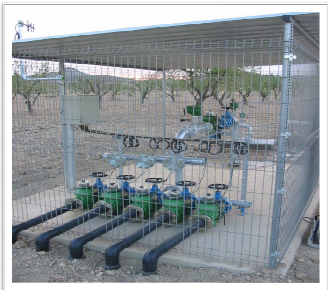
Photos .3.V. bornes d'irrigation.
