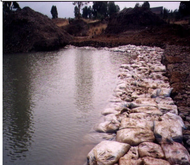
Fig V-5 des retenue en big-bag
