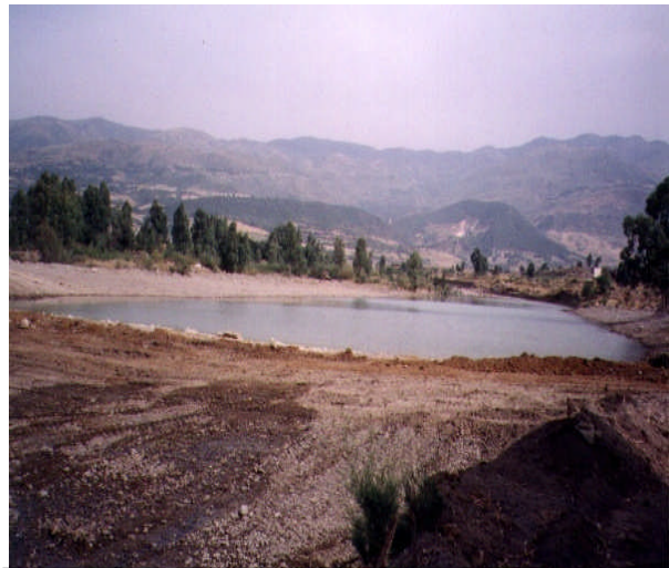
RETENUE EN BIG BAG DE L'OUED EL HARRACH – HAMMAM MELOUANE – VU DU PLAN D'EAU A PARTIR DE LA DIGUE CI-DESSUS ET REPARTITION DES SACS ( BIG-BAG ) ET GABION DE PROTECTION CI-DESSOUS.
