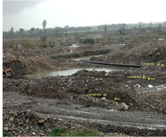
Fig V-3 Bassin de décantation et préparation des conduites 1, 2, et 3 vers les bassins d'infiltration
