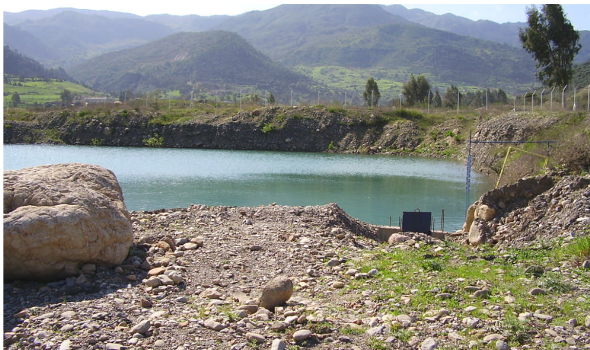
Fig IV-10 : bassin de décantation du système ANRH avec vue d'une partie du bassin versant
