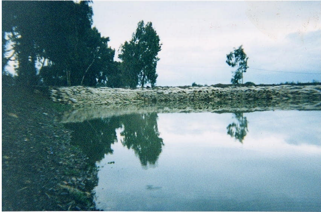
Fig IV-8: vue en amont de la retenue en big bag
