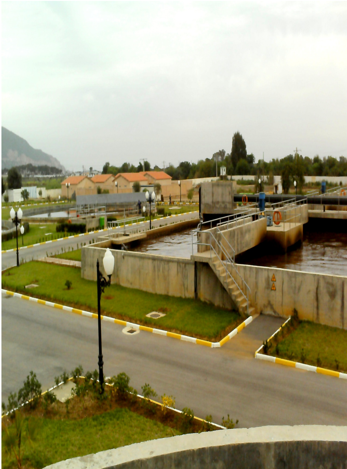
Figure V.1 : La station d'épuration de CHANOUA.
