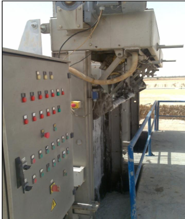
**Figure III.2:** Dégrilleur
