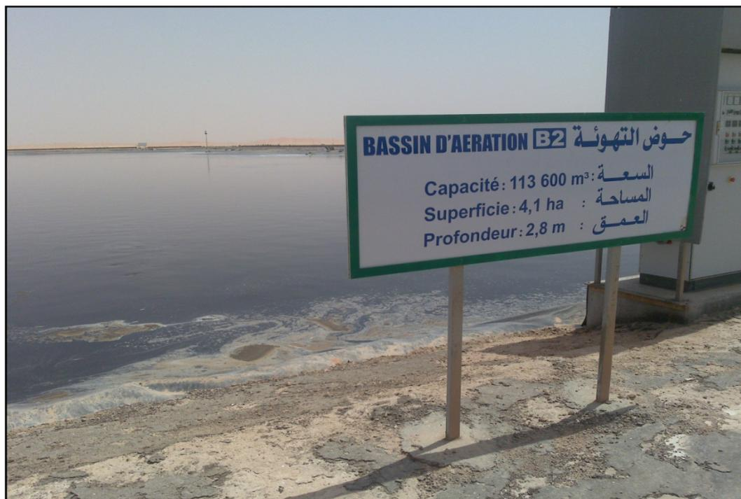
**Figure III.7:** Bassin d'aération (2<sup>ème</sup> étape)
