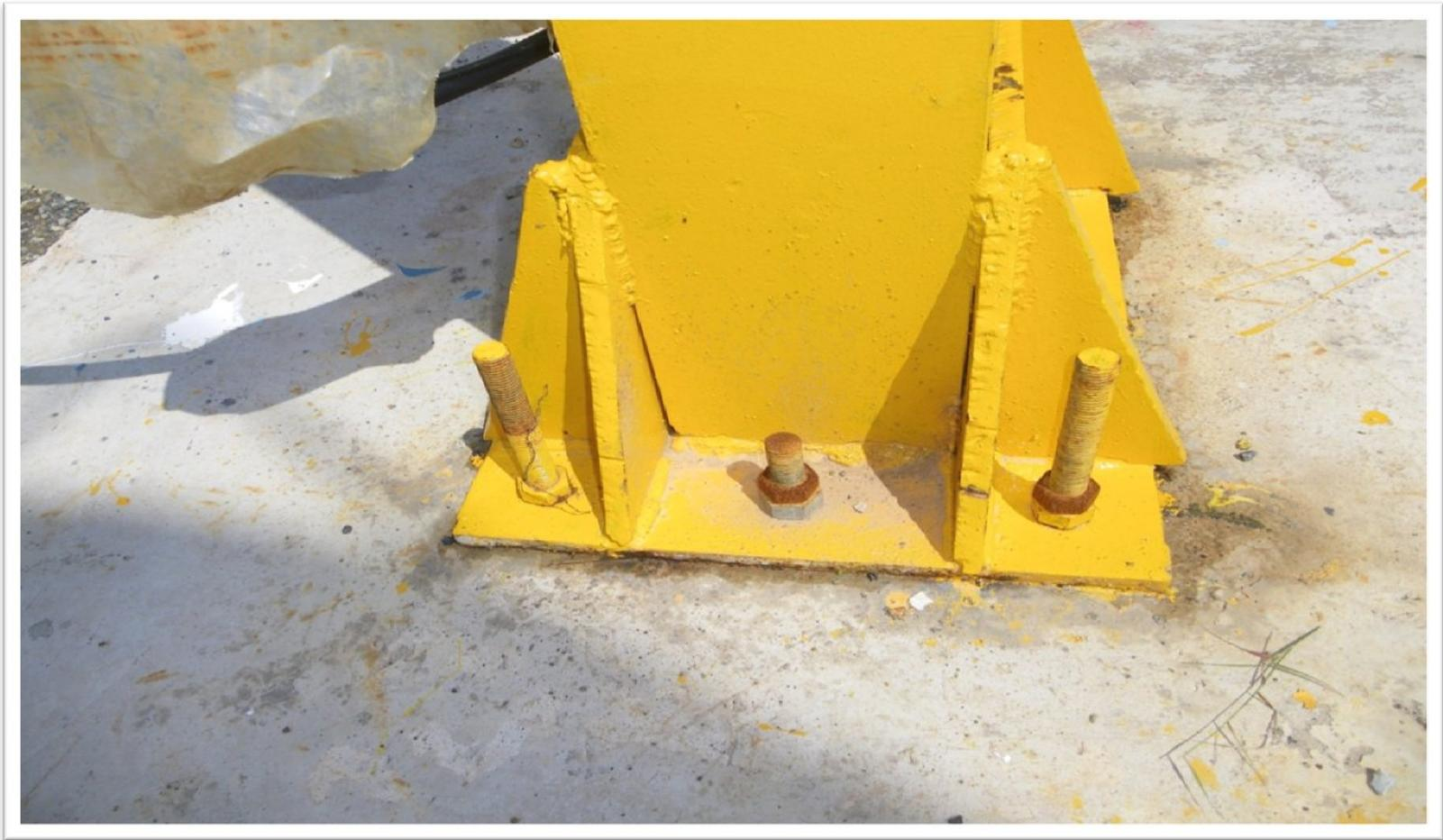
Figure III.2 .Les boulent de fixations de pont roulant
