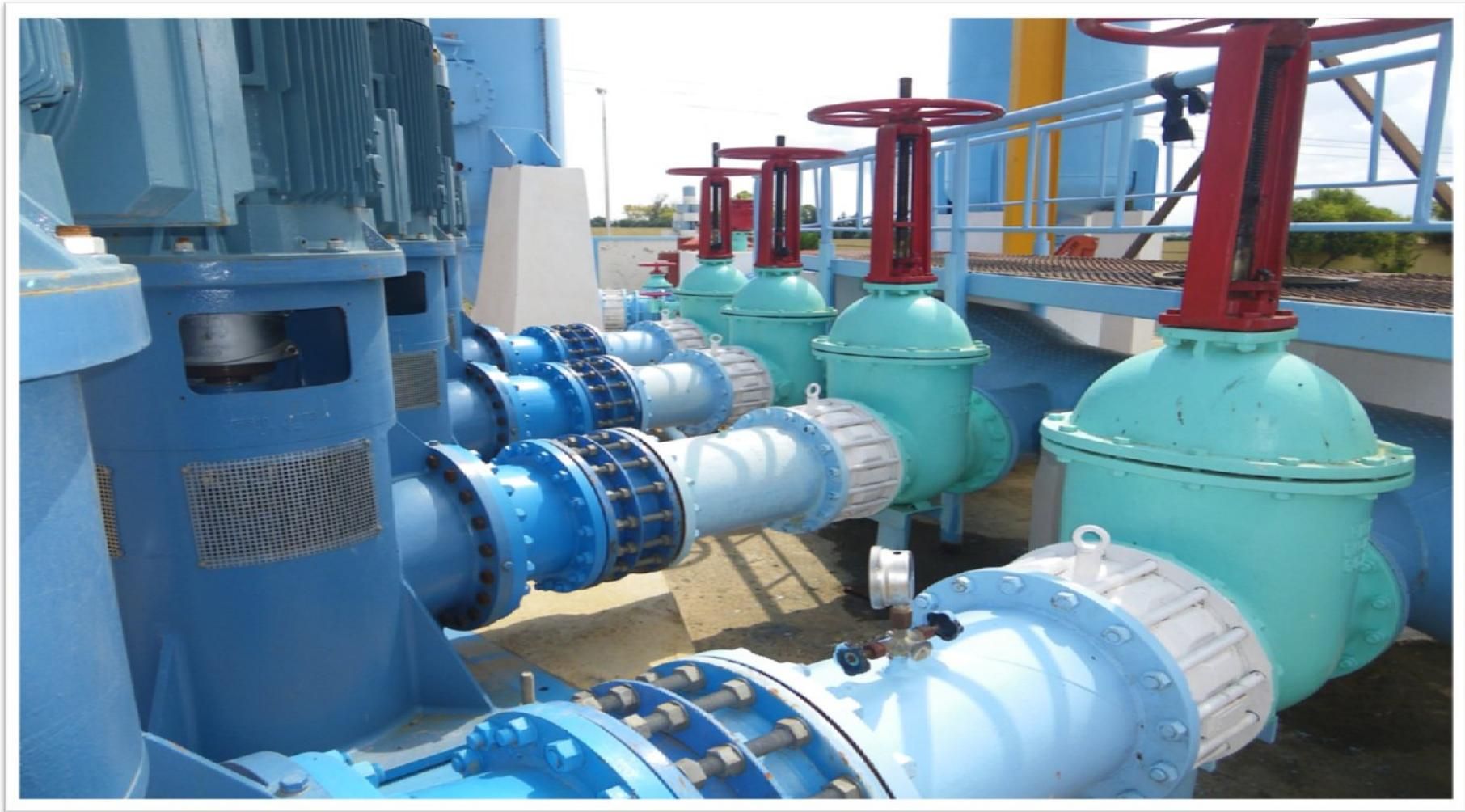
Figure III.4.les vanne porte est installée sur chacun des quatre conduites de refoulement connectant des pompes au collecteur principal
