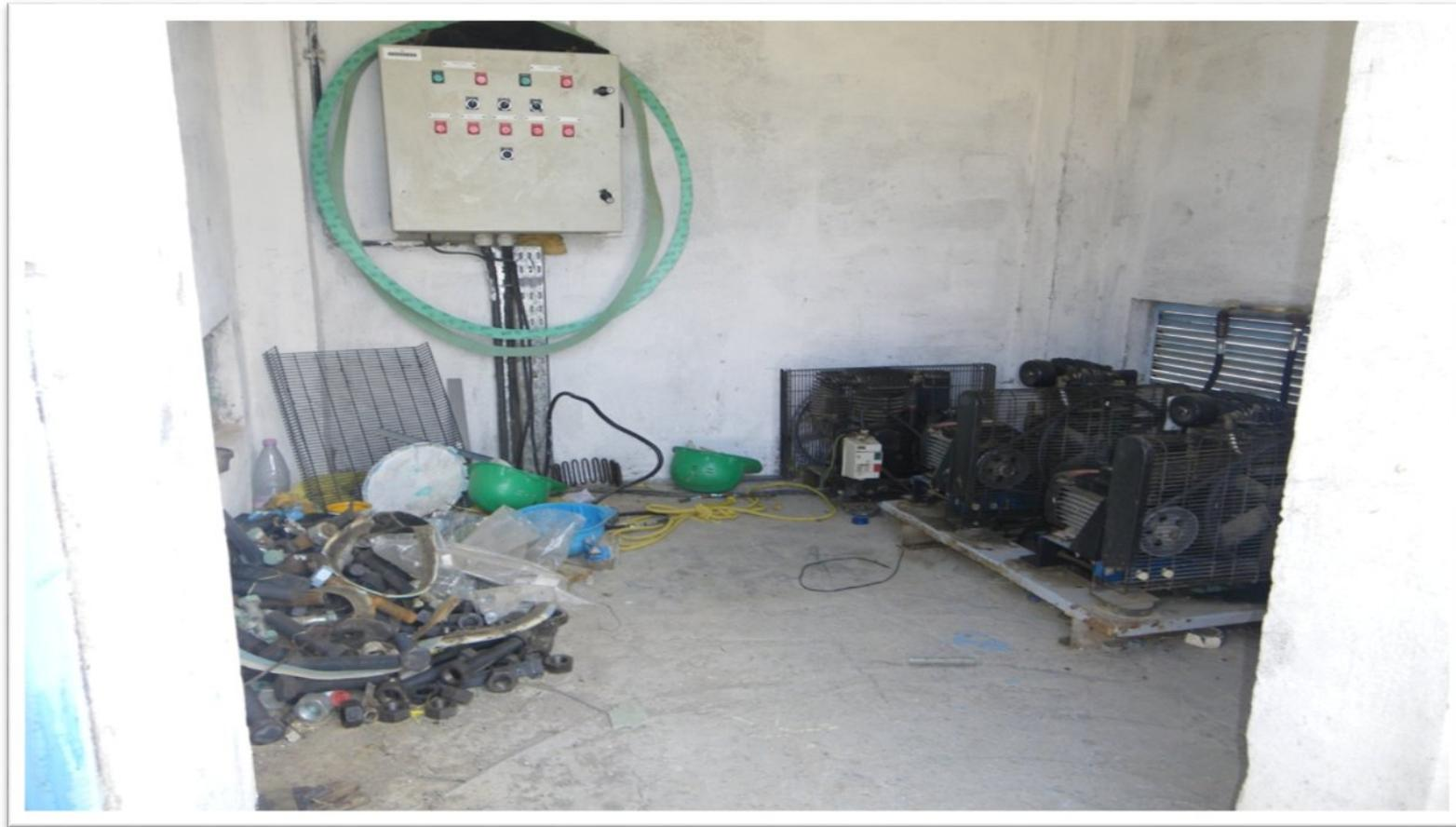
Figure .III.1. Les compresseurs d'aire installés pour le maintien de la pression d'air requise à l'intérieur des réservoirs anti-bélier.
