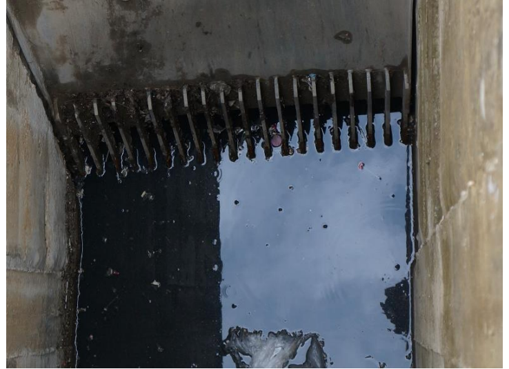
Figure III.3 : Dégrilleur grossier
