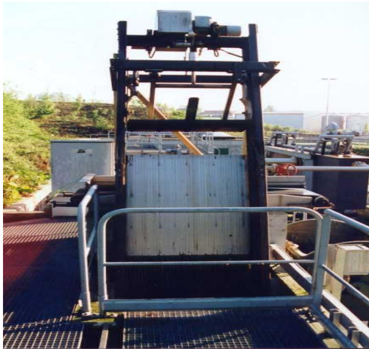
Figure IV.1 : Dégrilleur courbé
