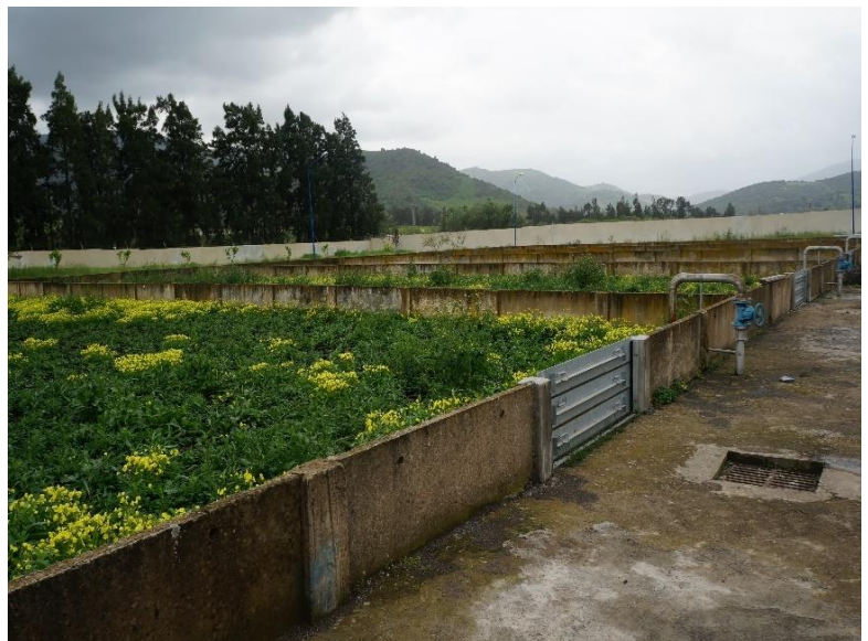
Figure III.10 : lits de séchage
