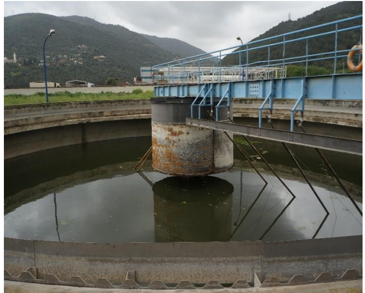
Figure III.7 : Bassin de décantation
