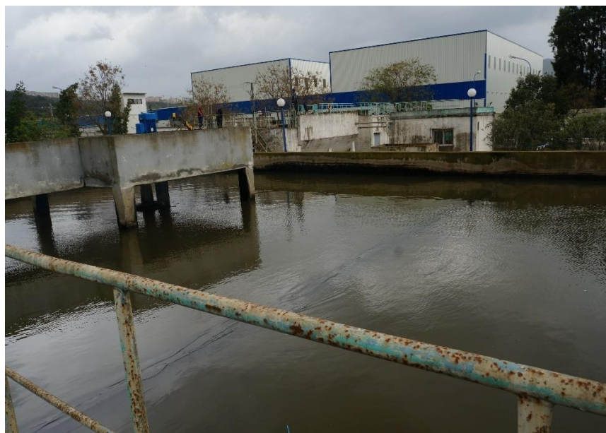
27 Figure III.6 : Bassin d'aération
