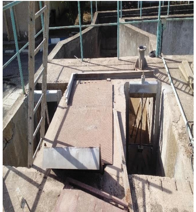
Figure III.4 : Dégrilleur moyen
