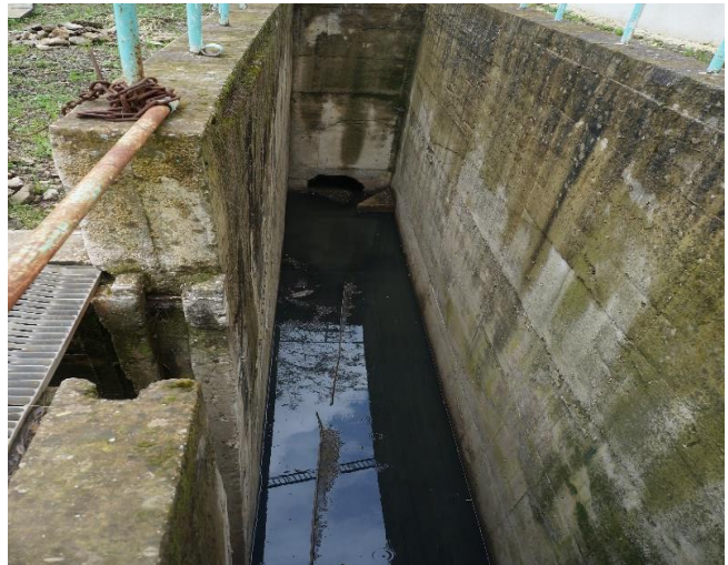
Figure III.2 : Déversoir d'orage
