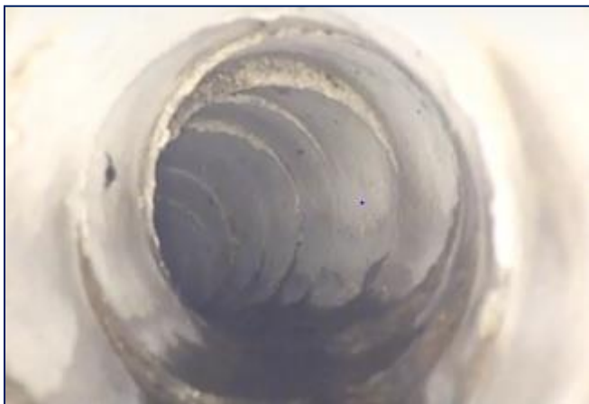
Fig N°II.23 : vue amont de la conduite en Béton DN 300(Situation :EU/CS-M33/ R372)
