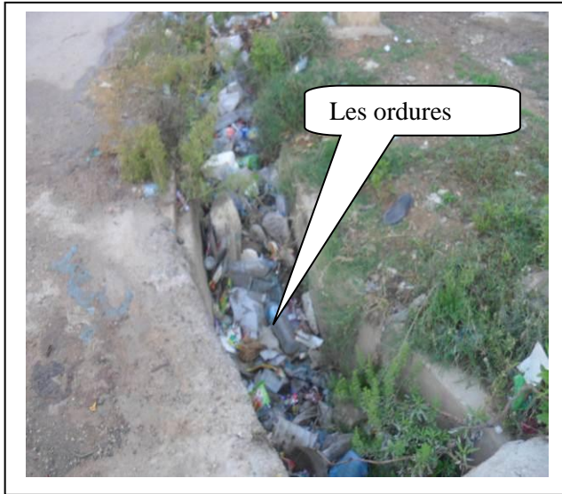
Fig n°II.44 : le caniveau des eaux pluviales En béton
