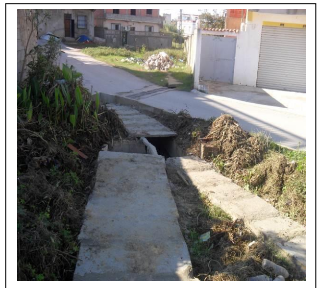
Fig n°II.43: Vue extérieur du caniveau en dalle
