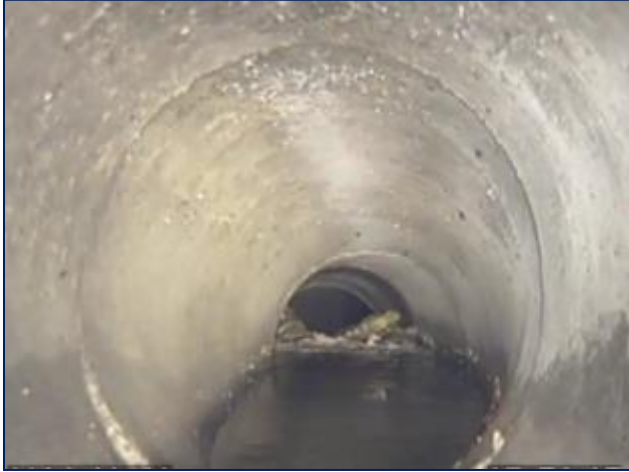
Fig N° II.25 : Vue Aval de la conduite en Béton DN 400 (Situation : EU/CS-M17/ R539)
