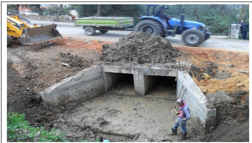
Figure n°II.50 : ouvrage des eaux pluviales de « galerie C » coté amont
