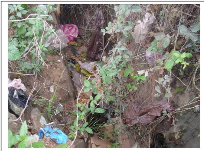
Figure N°II.53 : Caniveau des eaux pluviales Rectangulaire
