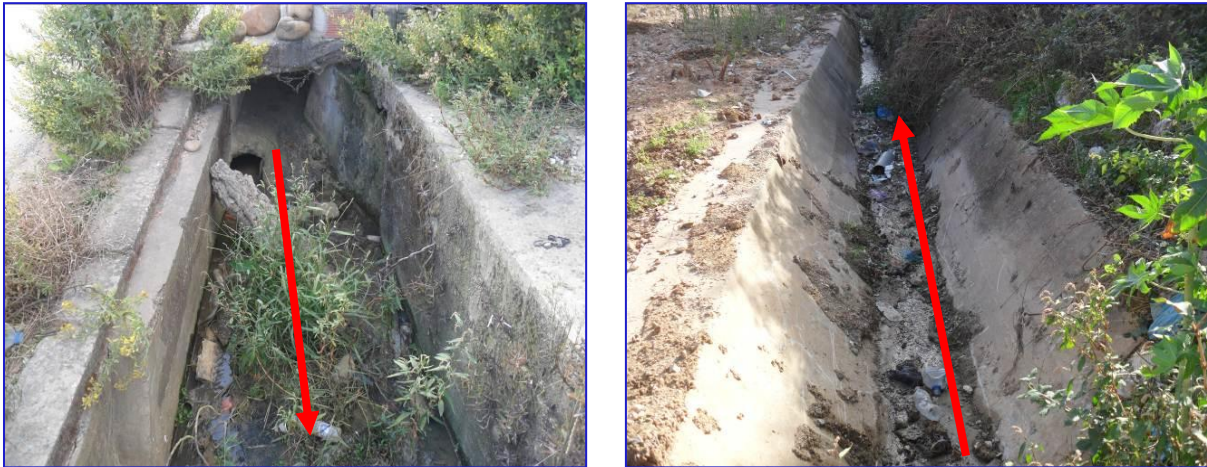
FigN°II.30: vue générale du caniveau rectangulaire Fig n°31:vue générale du caniveau des eaux pluviales
