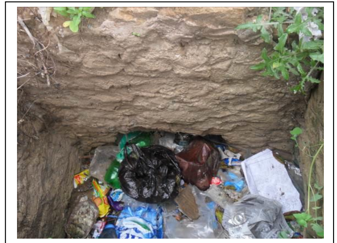
Figure N°II.54 : entrée des eaux pluviales a la galerie
