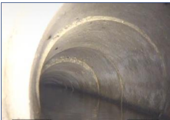
Fig N°II.22 :Vue amont de la conduite en Béton DN 300(Situation :EU/CS-M33/ R372)
