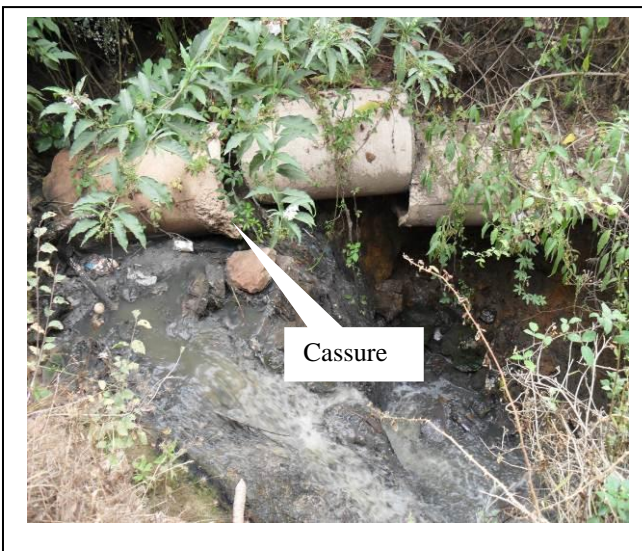
Figure n°II.39 : Etat physique Du collecteur principal CP-M02
