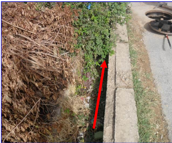
Fig N° II.26 : un caniveau rectangulaire (40 x 50) cm
