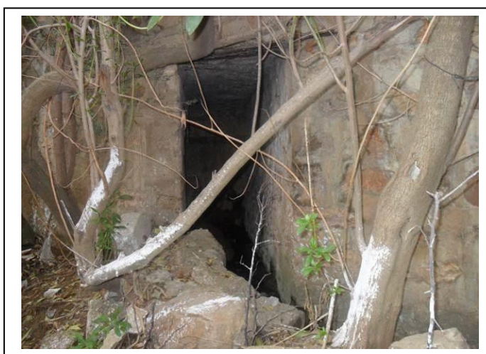
Figure n°II.47 : Rejet n°2 des eaux pluviales
