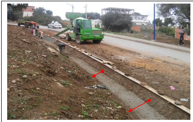
Figure N°II.52 : Caniveau des eaux pluviales de forme trapézoïdale
