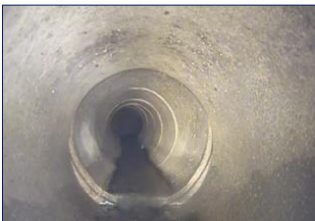
Fig N°II.24 :Vue amont de la conduite en Béton DN 400(Situation :EU/CS-M17/ R539)
