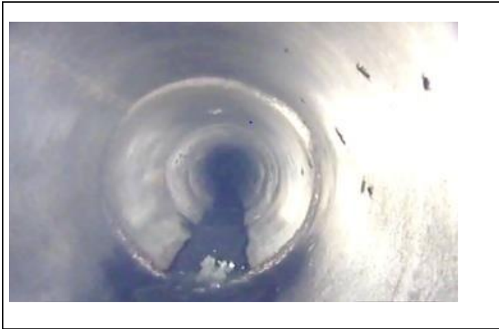
Figure n°II.38 : résultat de l'inspection télévisée Du collecteur principal CP-M01 (amont)
