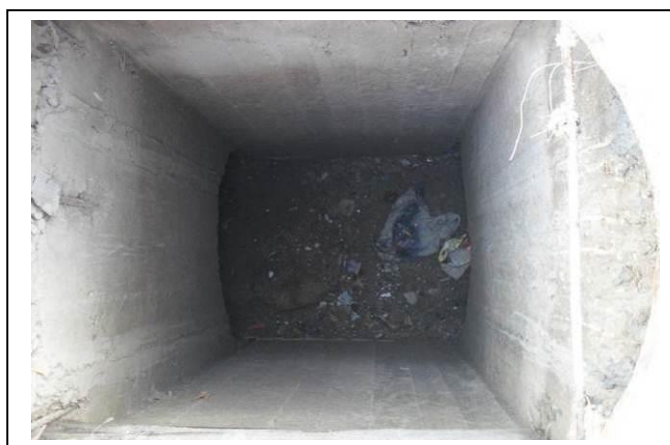
Figure N°II.34 : regard de la canalisation DN800 béton (eaux pluviales)
