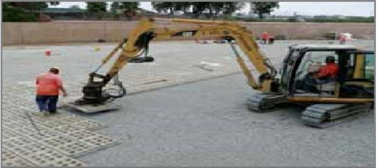
**Figure VI.2 :** mise en place des matelas ACBM
