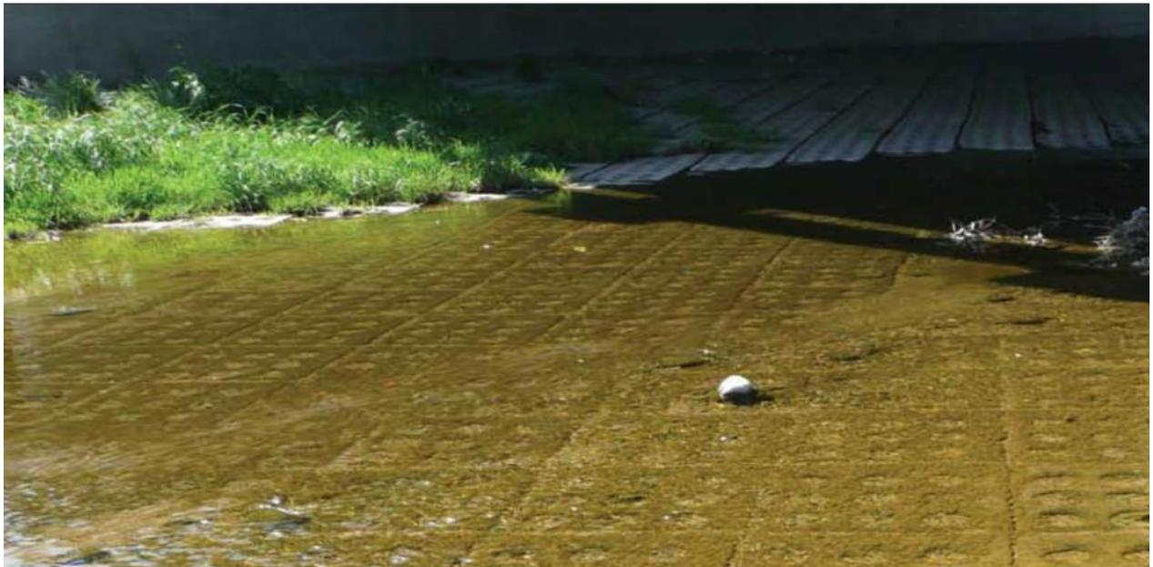
**Figure VI.1** : disposition de matelas ACBM dans un canal
