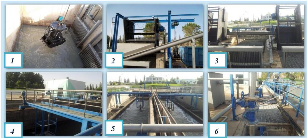
**Figure III.1** : Unité de prétraitement de la station d'épuration de la commune de SAIDA, Juillet 2014 (1 : piège à sable, 2 : Vis d'Archimède, 3 : dégrilleur ,4 : pont racleur ,5 : dessableur-déshuileur, 6 : Extraction des huiles (Pompe)).
