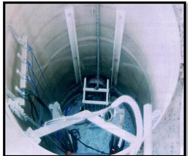
Figure II-1-b : Relevage grâce à une pompe [13]
