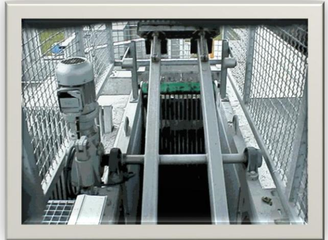
Figure II-3 : Dégrillage mécanique [23]
