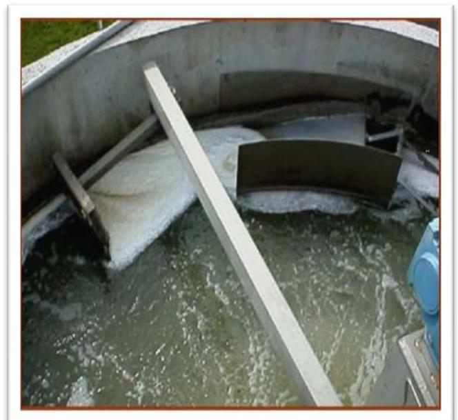
Figure II-5: Racleur des graisses [23]
