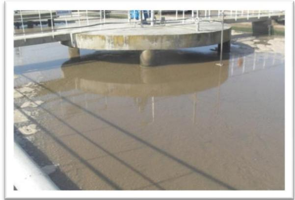
Figure IV-6-b : bassin d'aération en arrêt
