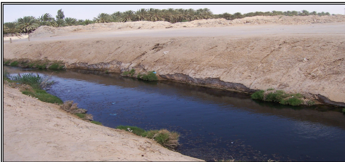
Fig.42 : Vue de section du canal d'Oued Righ Nord
