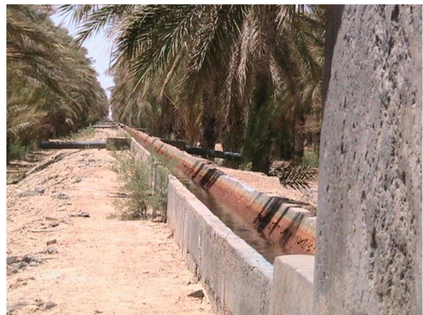
Fig.37 : Séguias En Béton
