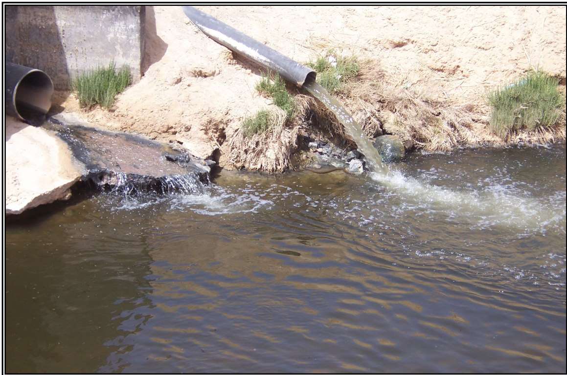
Fig. 53 : Les rejets des eaux usées dans le canal d'Oued Righ
