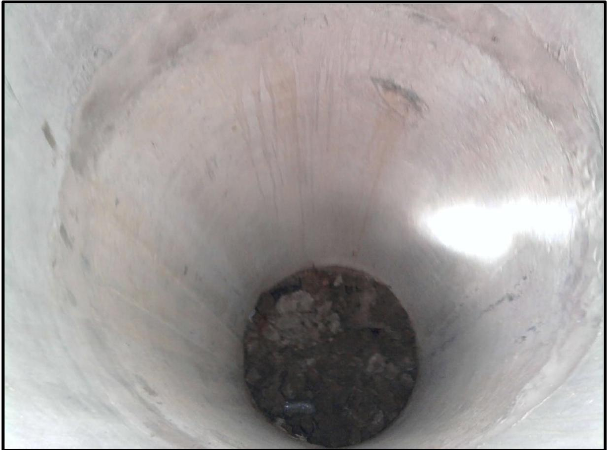
On observe que les collecteurs sont pas visible alors c'est ce qu' explique le manque de passage de l'eau par le collecteur et ce qu'il provoque la diminution de la vitesse d'infiltration puis la stagnation de l'eau sur la surface, ceci est l'un des problèmes qui influence sur le bon fonctionnement du réseau.
