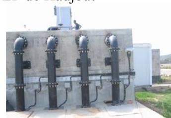
**Figure II.7:** Station de relevage de la STEP de Hadjout
