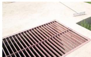
**Figure II.6 :** Dégrillage grossier de la STEP de Hadjout
