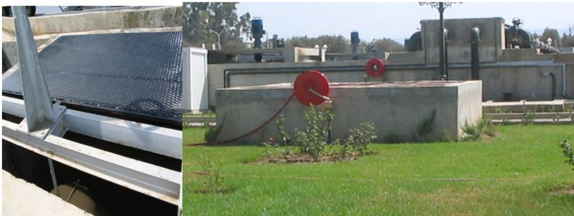
**Figure II.14 :** Poste de pompage des boues (à gauche) et un bassin d'équilibre (chambre de distribution) pour la répartition des eaux vers les deux décanteurs (à droite) de la STEP de la ville de Hadjout
