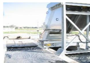
**Figure II.8 :** Dégrillage fin
