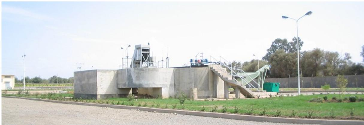
**Figure II.5 :** Bloc des traitements physiques (dégrillage grossier et fin ainsi que dessablage / déshuilage) de la STEP de la ville de Hadjout
