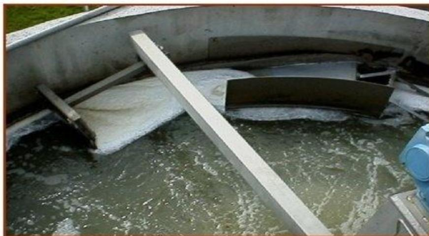
*Figure III.5 : Racleur des graisses*
