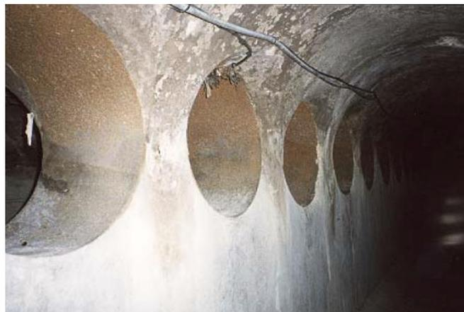
**Figure VII.6 :** Exemple d'un déversoir à type « trou dans le mur »
