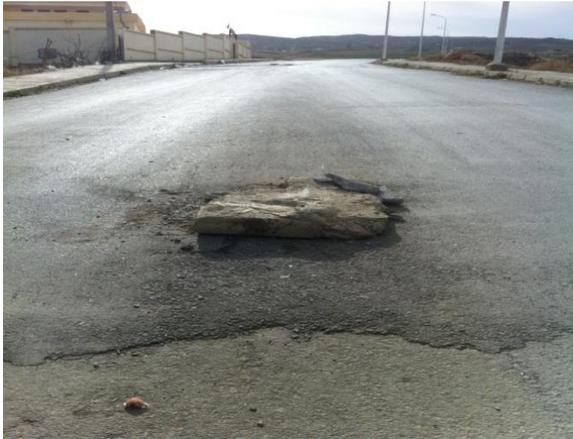
**Figure II.9 :** Cas d'un tampon remplacé par une dalle en béton (11/03/2016)
