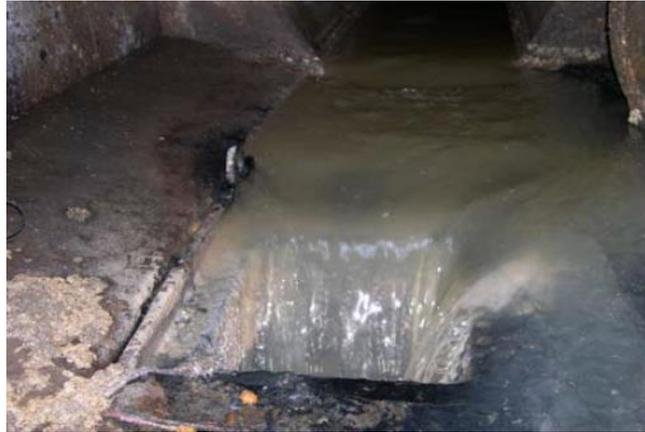
**Figure VII.5 :** Exemple d'un déversoir à ouverture de radier
