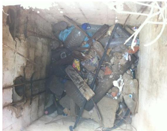
**Figure II.8 :** Absence du tampon, dépôts et débris et aciers apparents à l'intérieur du regard (11/03/2016)
