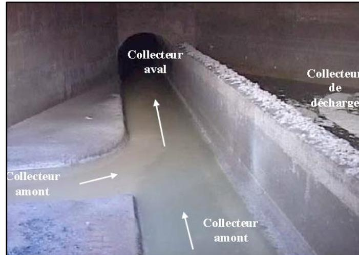
**Figure VII.8 :** Exemple d'un déversoir d'orage latéral
