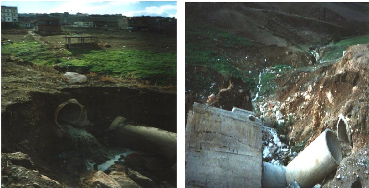
**Figure II.13** : Rejet N°2 – Déversoir d'orage et conduite emportés ([10], 14/01/2015)
