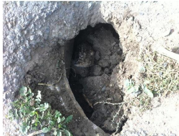
**Figure II.10 :** Ce même regard révèle une importante infiltration de gravats du fait de l'absence du tampon d'origine (11/03/2016)
