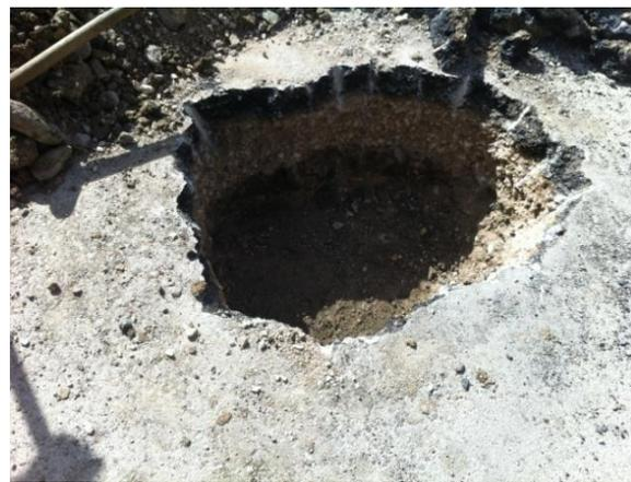
**Figure II.11 :** Dégagement d'un regard sous chaussée, on remarquera les hauteurs de couverture importantes (11/03/2016)
