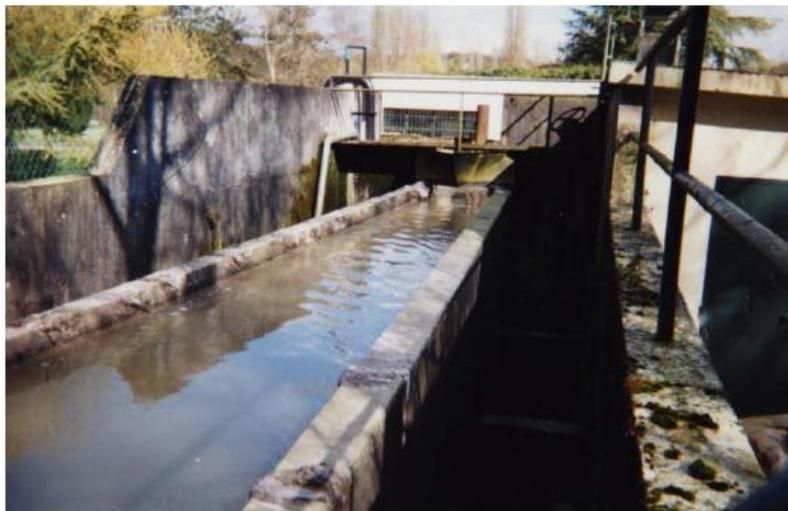
Figure VII.9 : Exemple de déversoir à seuil double [10]
