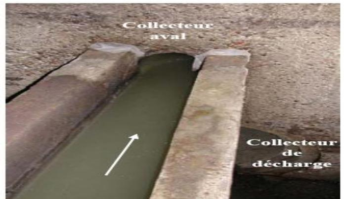
Figure VII.8 : Exemple de déversoir latéral à seuil simple
