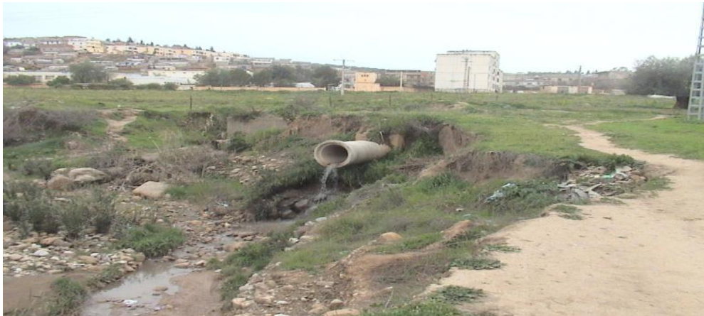
Figure III. 2. La sortie de la conduite
