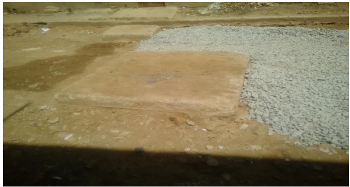
Figure III. 5.Regard en bon état
