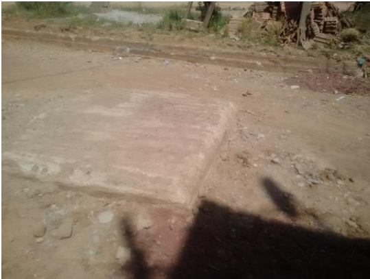
Figure III. 4.Regard en bon état
