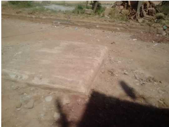
Figure III. 4.Regard en bon état
