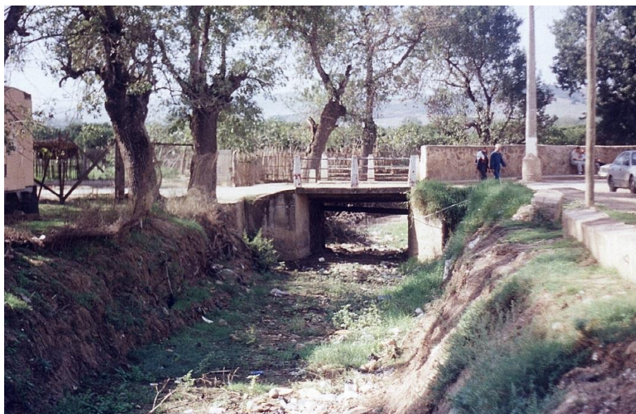
Figure IV.2 : Oued Kounda a l’intérieure du Village
