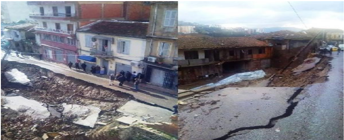
Figure I.1 : résultat après inondation du 17 février 2015
