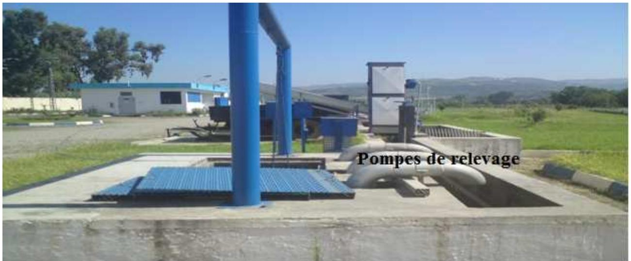
Figure III-2 : Pompes de relevage
