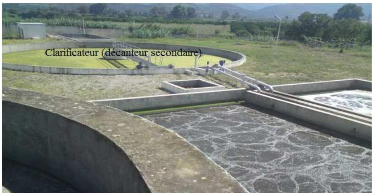
Figure III-7 : Clarificateur (décanteur secondaire)
