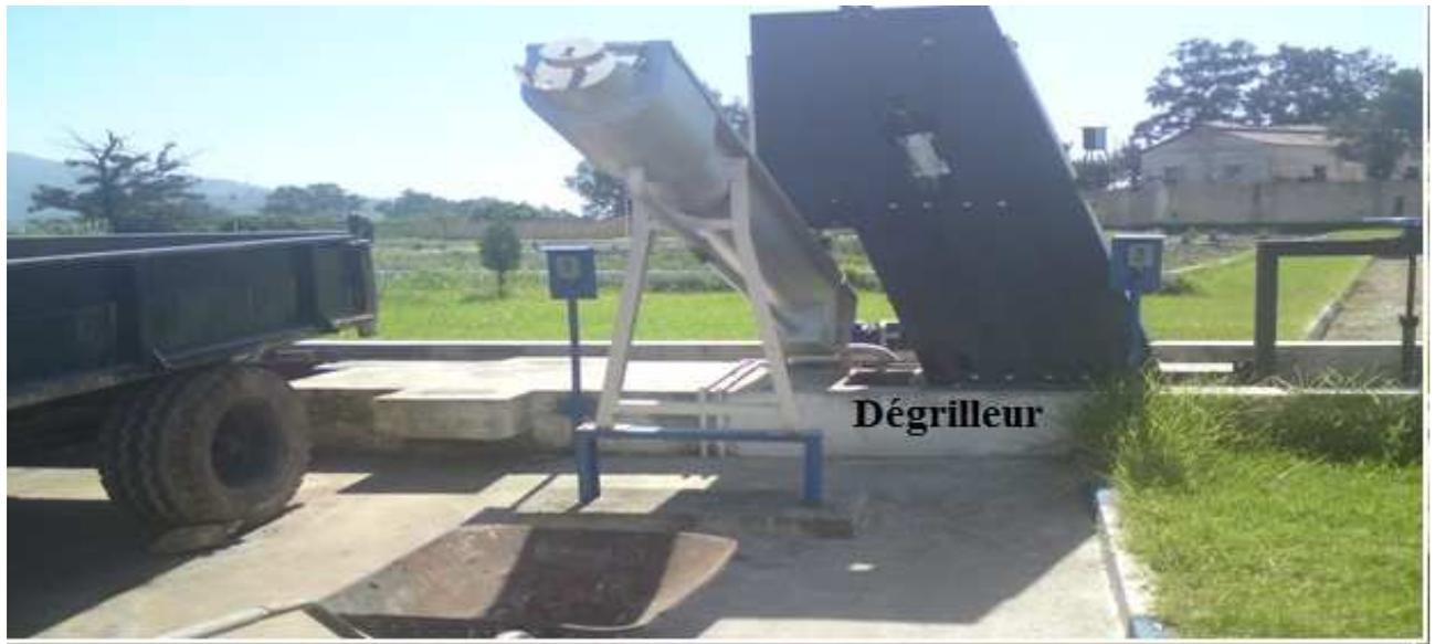
Figure III-3 : Dégrilleur
