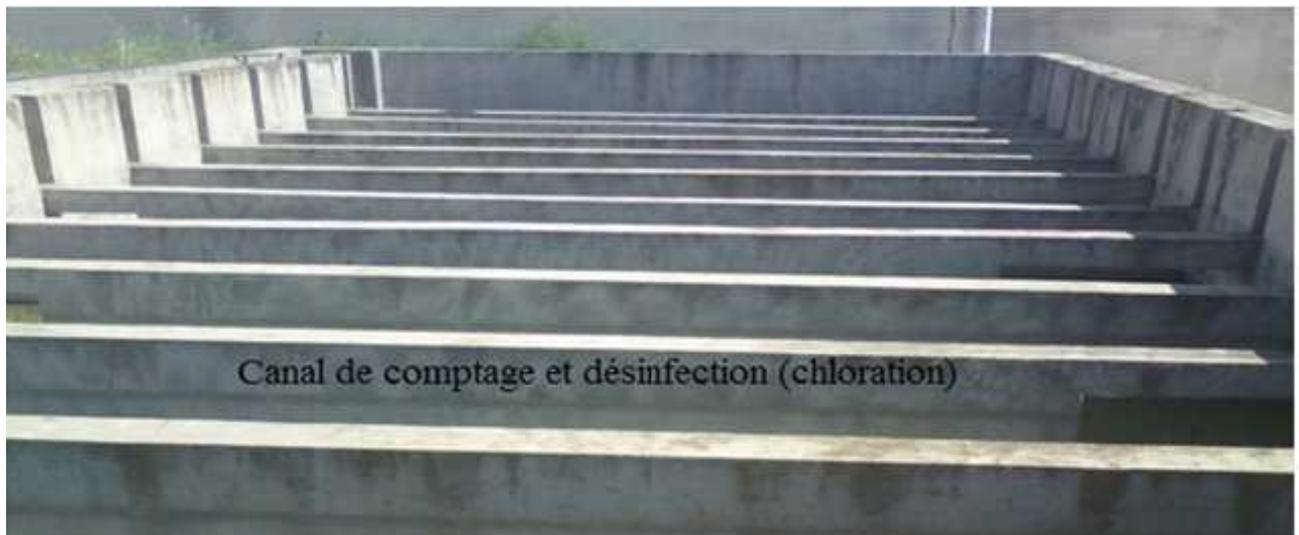
Figure III-8 : Canal de comptage et désinfection (chloration)
