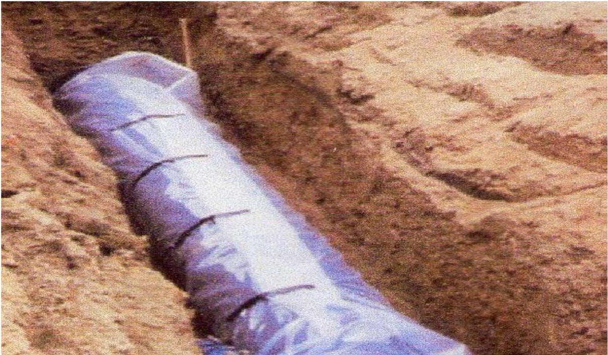
**Figure VI.2:** Installations de tuyaux recouverts d'une protection en polyéthylène
