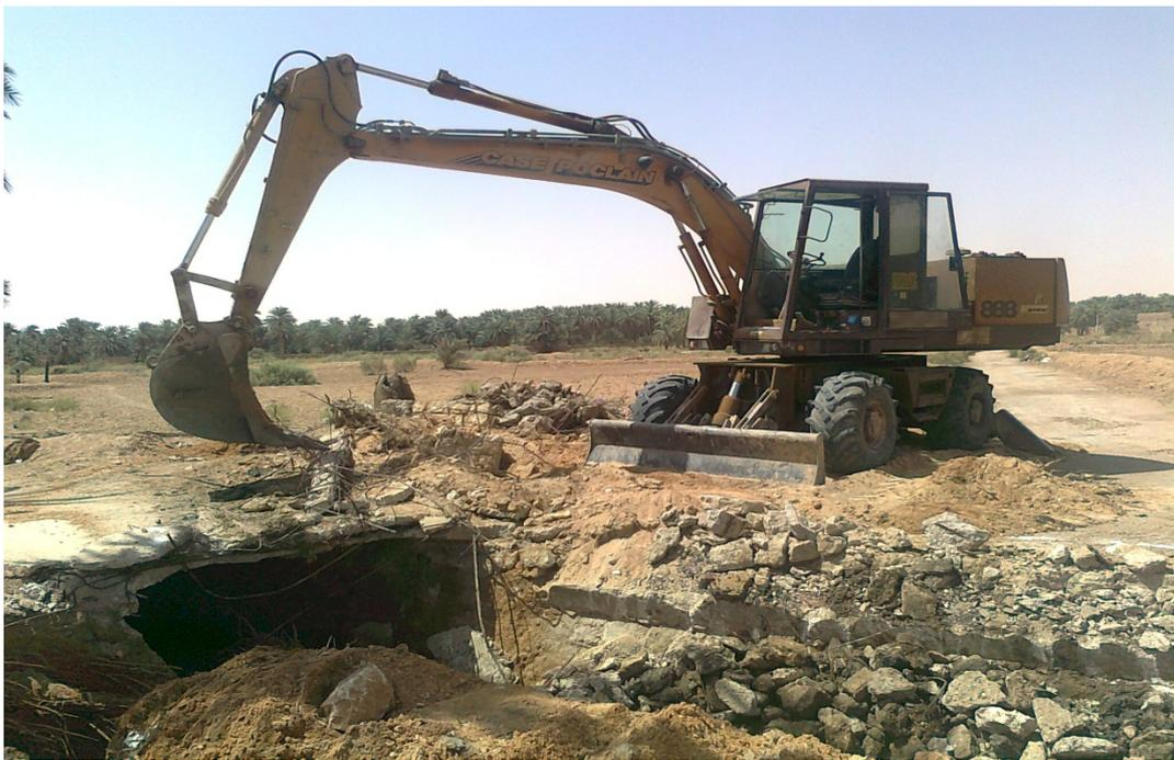
**Fig.VIII.1 Entretien du système de drainage (El-Menia)**
