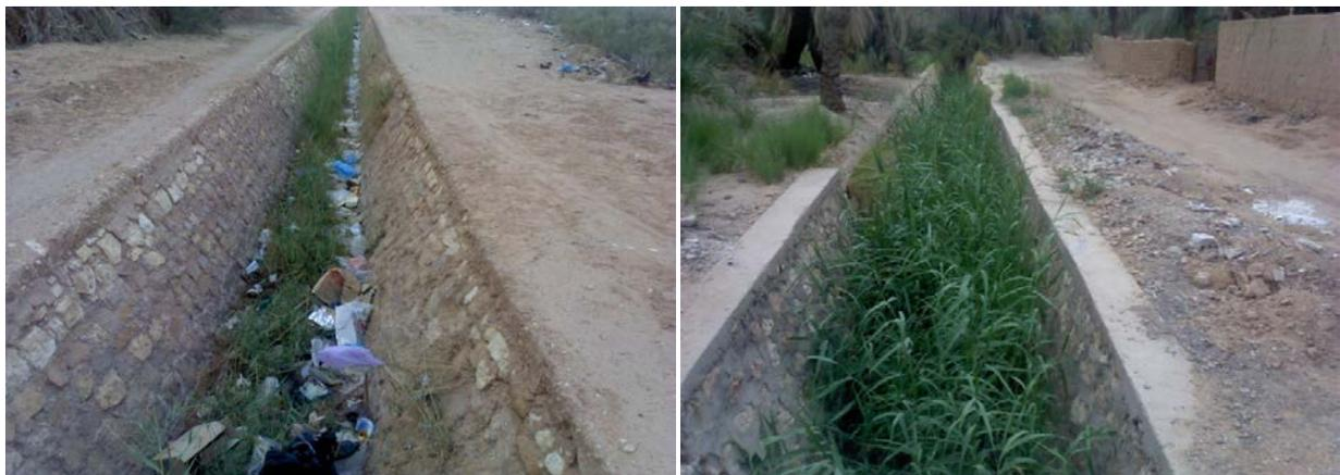
Fig.VIII.2 : Obstructions naturelle du système de drainage (El-Menia)
