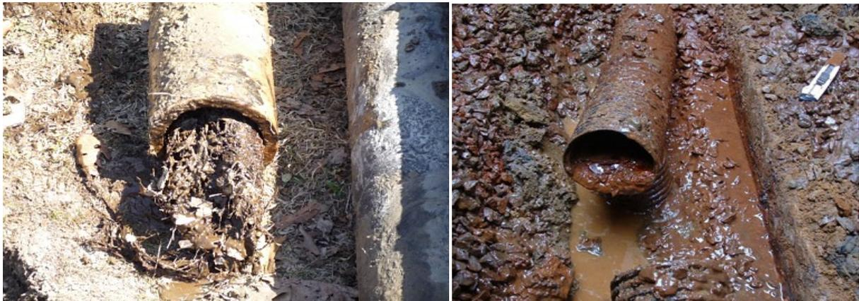
Fig.VIII.3 Colmatage des drains
