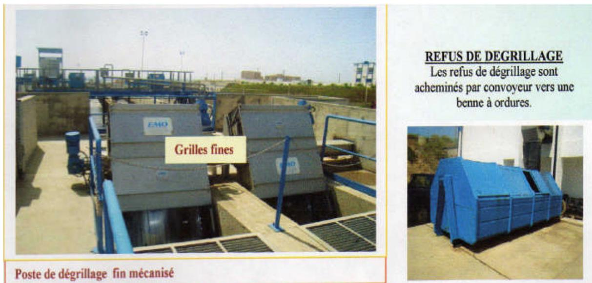
**Figure II.1 :** Déversoir dorage et poste de dégrillage fin mécanisé
