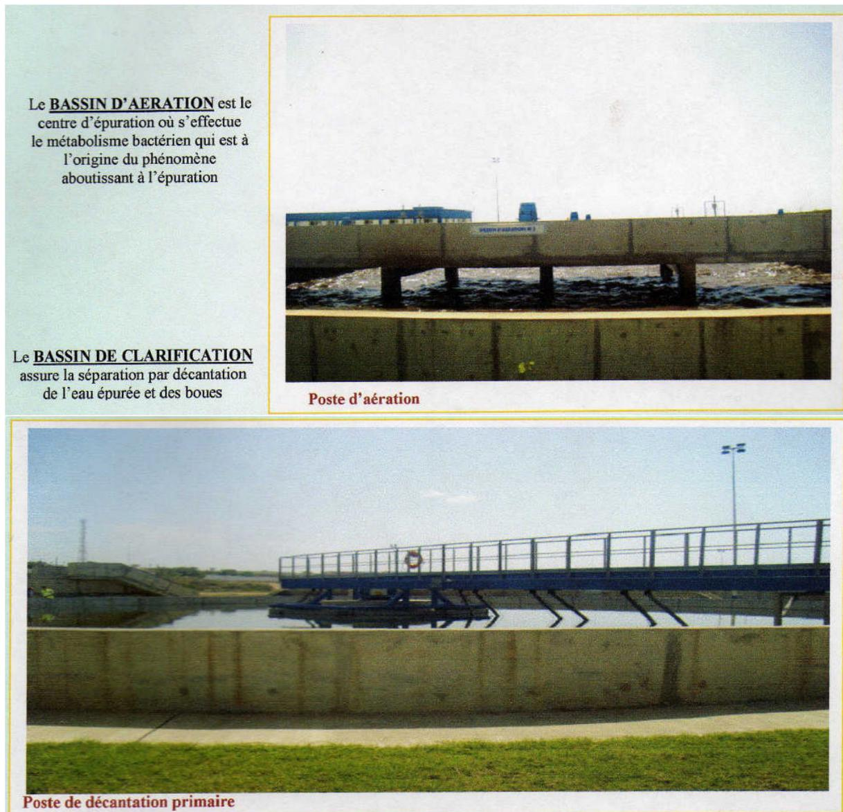
Figure II.3 : poste d'aération et de décantation primaire
