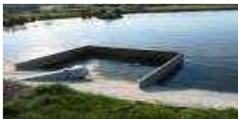
**Figure IV.4 : Dégraisseur**
