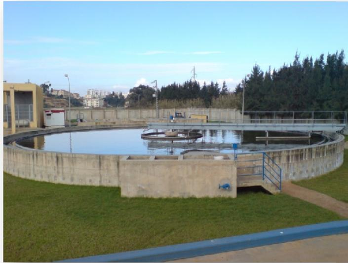
**Figure III-07 : Décanteur secondaire –clarificateur
