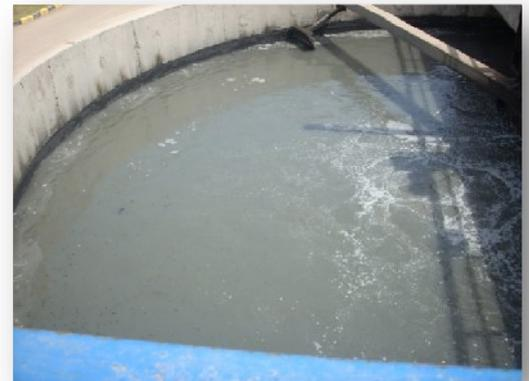
**Figure III-04 : Dessableur-dégraisseur de La STEP de Boumerdes**
