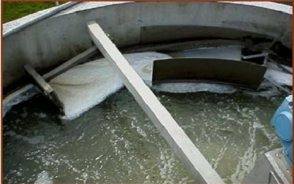
**Figure II-05 : Racleur des graisses**
