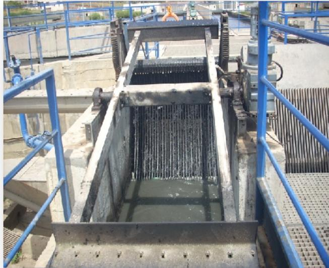
**Figure III-03** : Dégrilleur de la STEP de boumerdes
