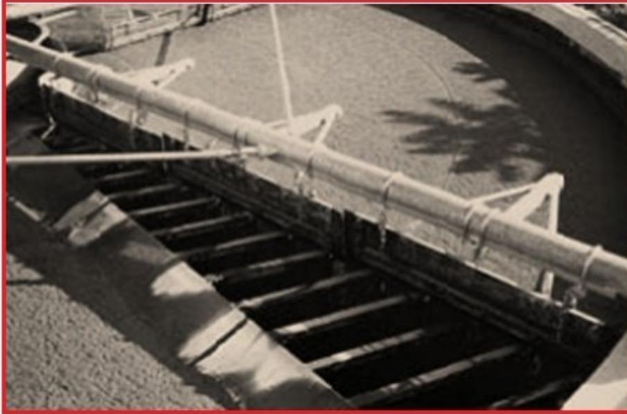
**Figure II-07 : Épaississement des boues par flottation**
