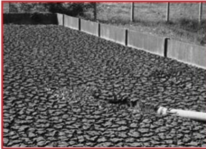
**Figure II-08: la technique des lits de séchage**
