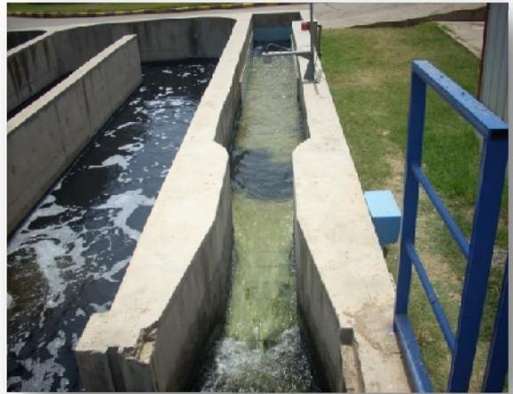
**Figure III-08 : Ouvrage de désinfection de la STEP De Boumeres**
