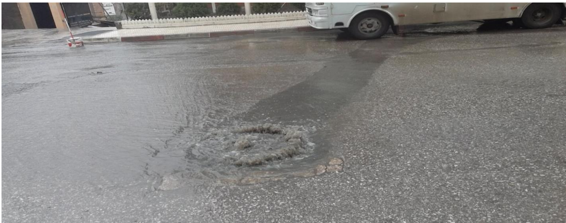
Figure III-5 : Débordement d'un regard (Sous dimensionnement).15-02-2016.
