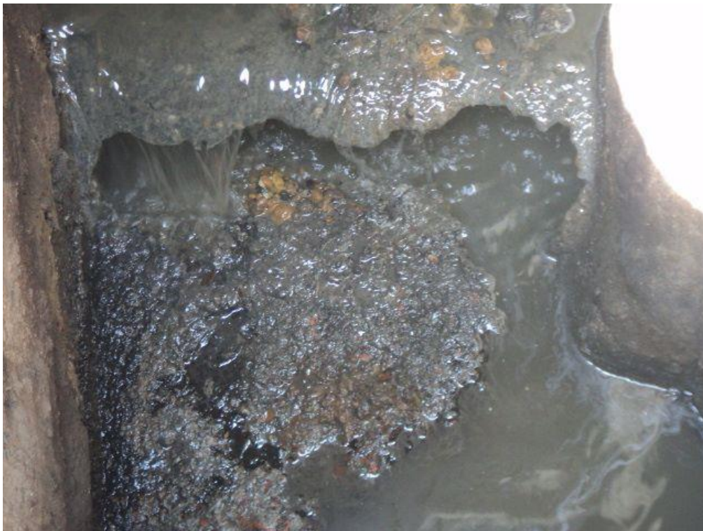
Figure III-10 : Attaque chimique.27-08-2015.
