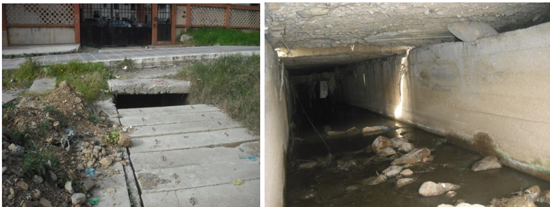
Figure I-5 : Oued Laazib, canalisé en galerie fermée. 12-06-2016.
