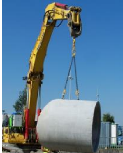
Figure VIII-3 : Pose de canalisation.
