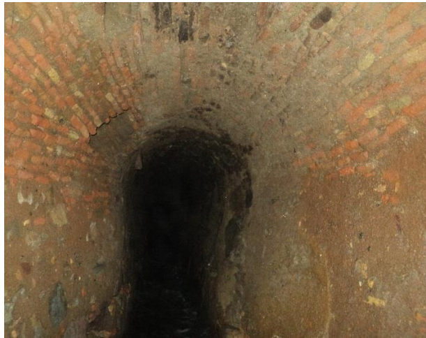
Figure VII-3 : Collecteur en brique sous forme ovoïdale.
