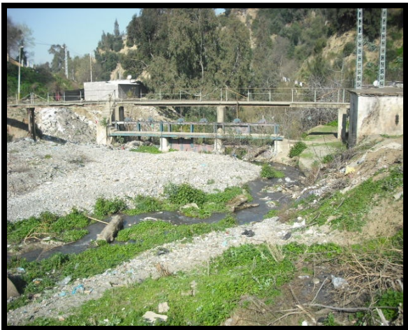
Figure II-14 Barrage déversoir coté amont (hors service) (06/20016)
