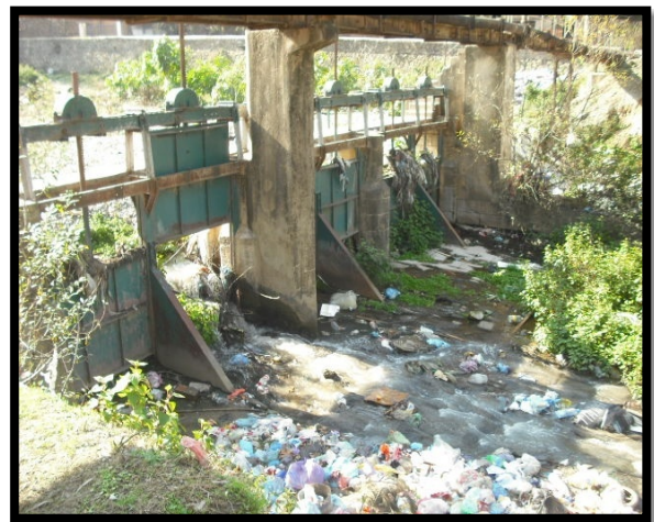
Figure II-19 Barrage déversoir coté aval (06/20016)
