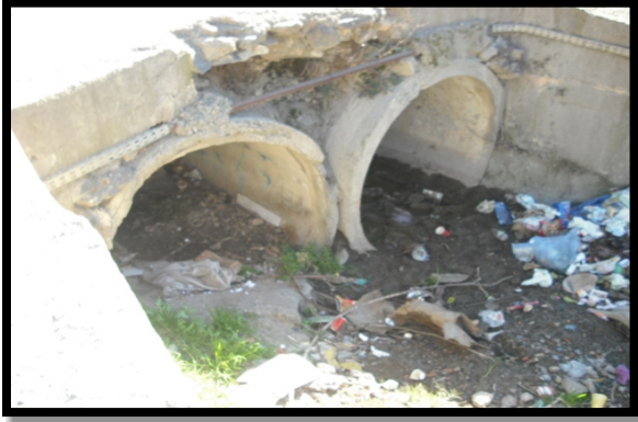
Figure II-8 L'amont de l'oued (2 × Ø1000) (06/2016)
