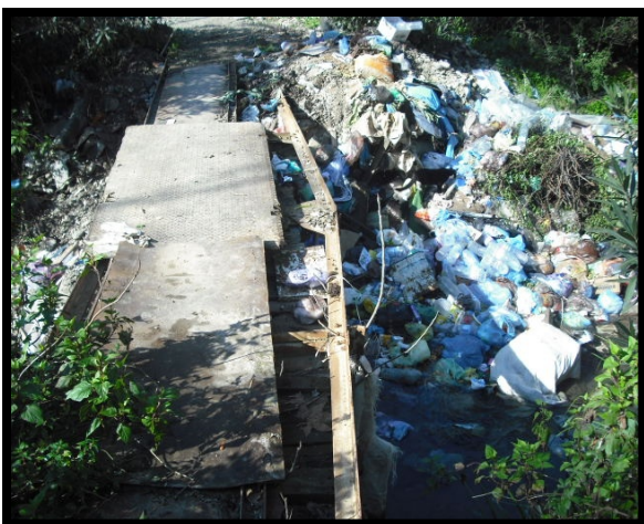
Figure II-8 Talus en pierraille, et décharge d'ordures (06/2016)
