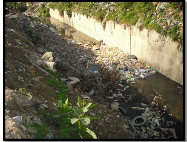
Figure II-22 Remblaiement dans le canal BA (06/20016)
