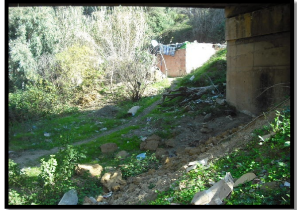
Figure II-9 Violation de la servitude de l'oued d'habitations sur la rive droite du lit mineur
