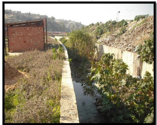
Figure II-24 Végétation dans le canal Béton armé (06/20016)
