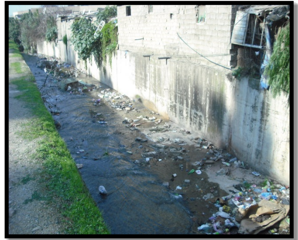
Figure II-23 Canal existant en Béton armé (06/20016)
