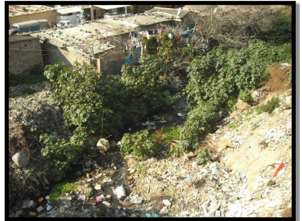
Figure II-17 Violation du lit mineur par des constructions (06/20016)
