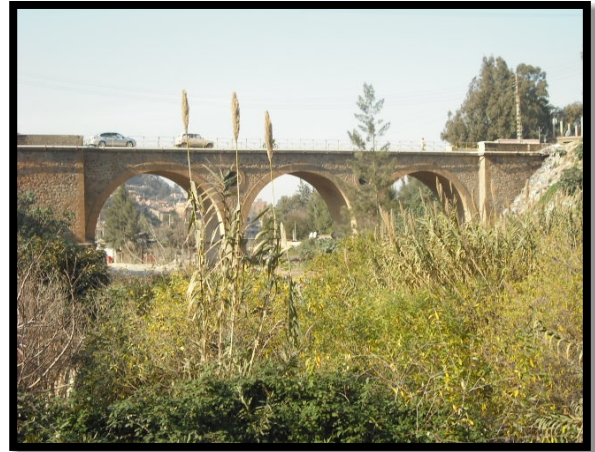
Figure II-16 Pont Routier en pierrailles (06/20016)
