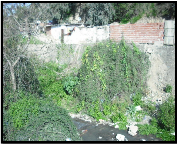
Figure II-12 Groupe d'habitations au bord de la berge RD (06/20016)
