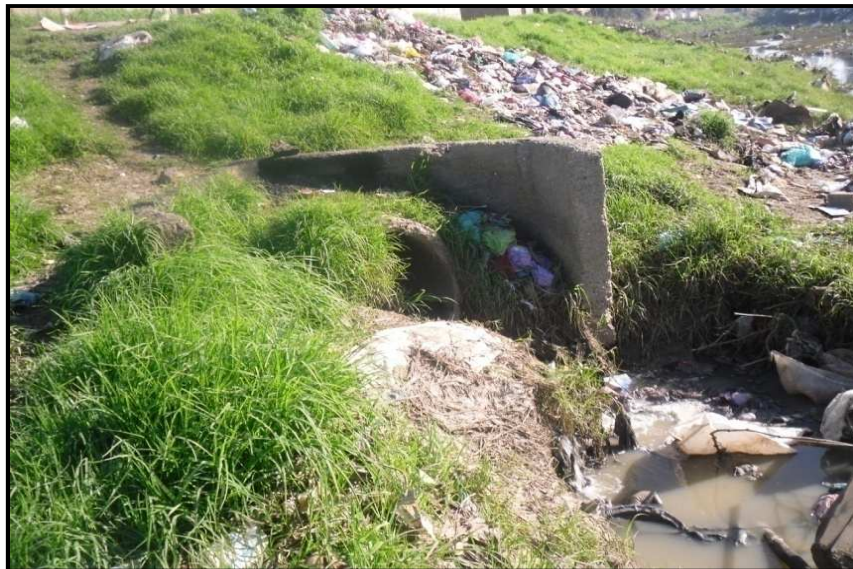
Figure N°III.3 : Rejet Ø500 (Hai El-Nasr)
