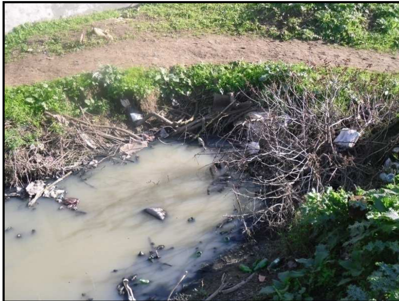
Figure N°III.1 : Rejet Ø1500 à côté du complexe Hydraulique Rouïba.
