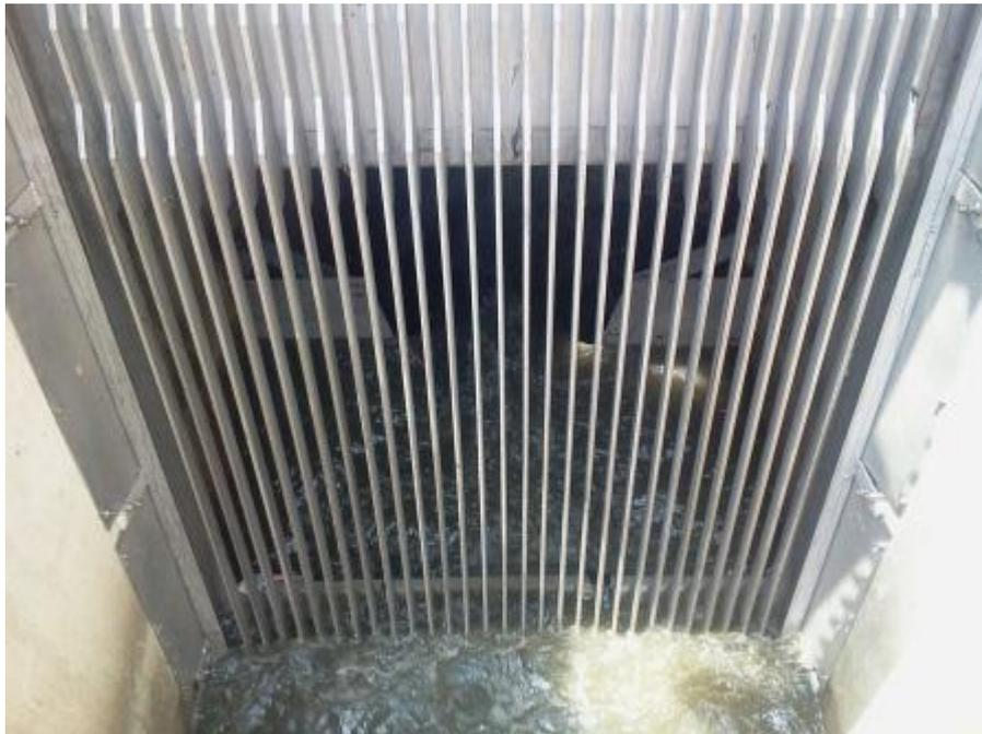
**Figure IV.2 :** Dégrilleur mécanique.
