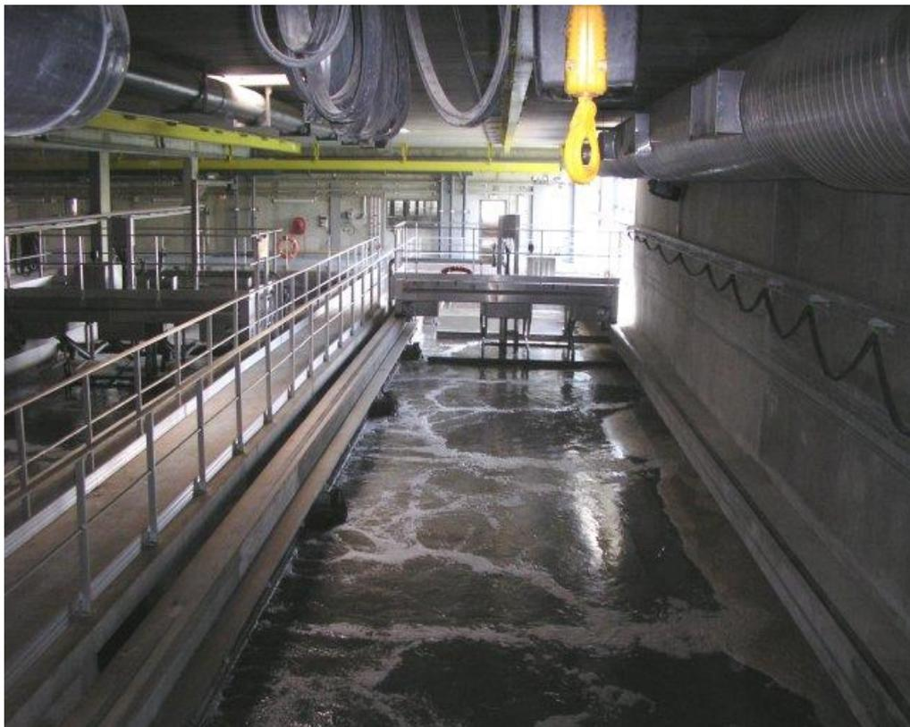
**Figure IV.3** : Dessablage, déshuilage et dégraissage dans un seul ouvrage
