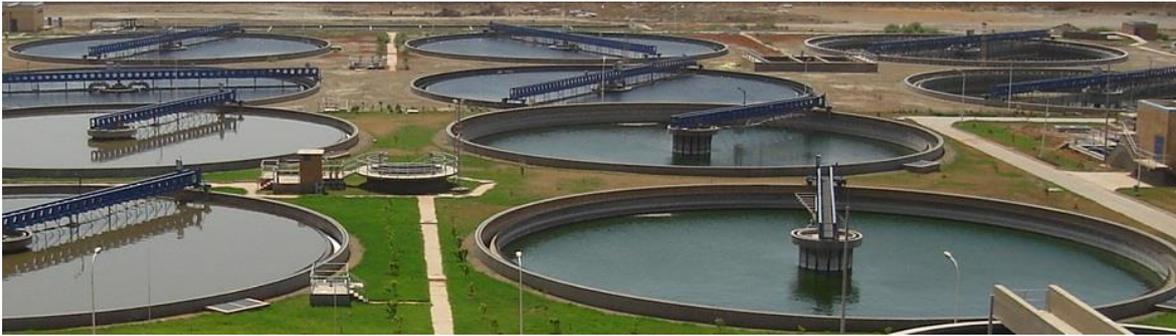
**Figure II-2** : Décanteur primaire circulaire.
