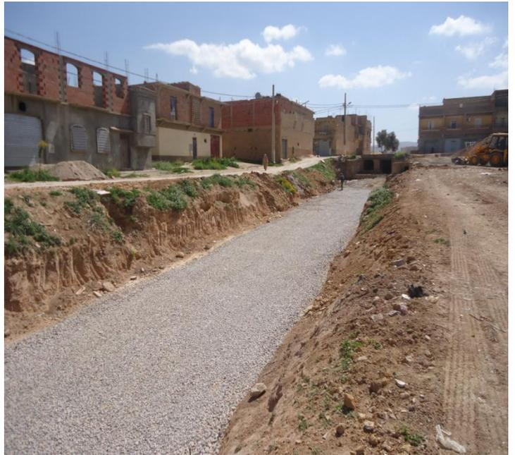
**Figure8:** pose du lit de gravier
