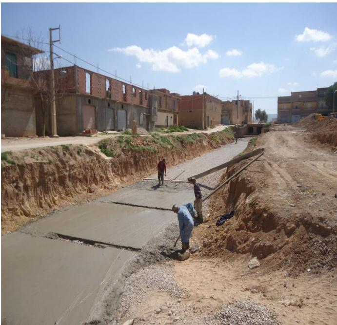
**Figure9:** Bétonnage du radier.
