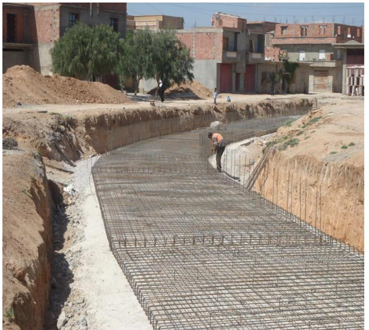
**Figure10:** Ferrailage du radier
