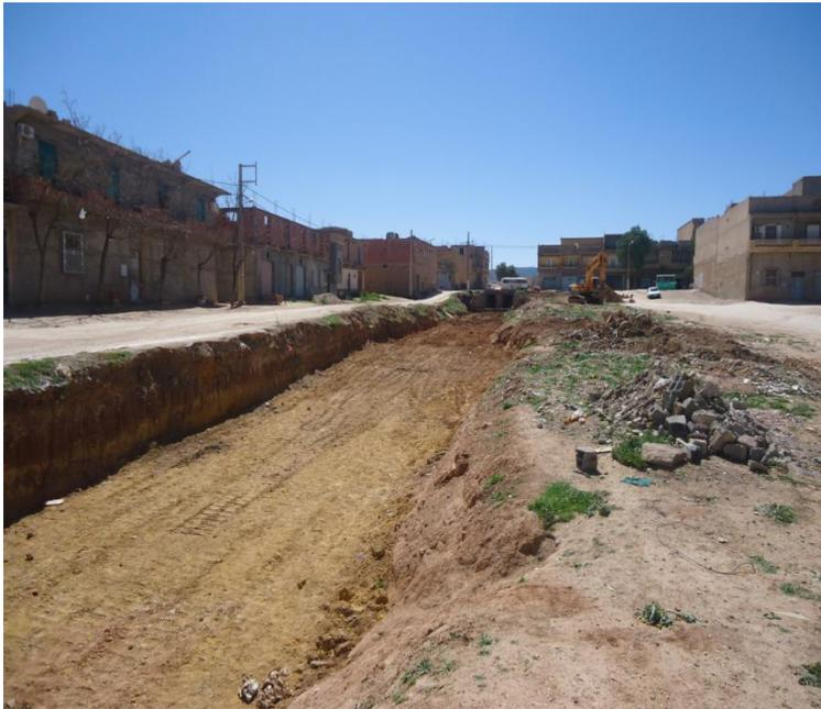
**Figure7:** Réalisation des fouilles par la pelle.
