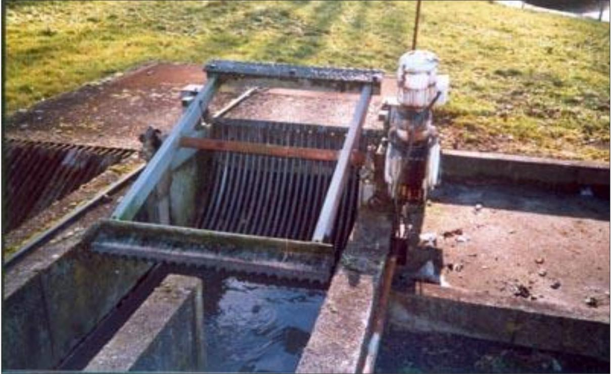
**Figure III.3:** Grille mécanique
