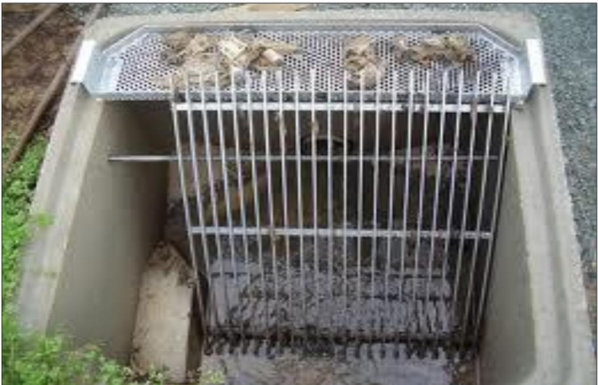
**Figure III.4:** Grille mécanique droite
