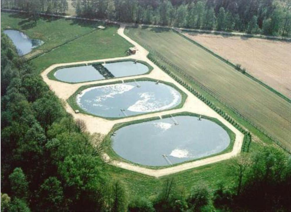
**Figure III.11** Système d'épuration par lagunes aérées.
