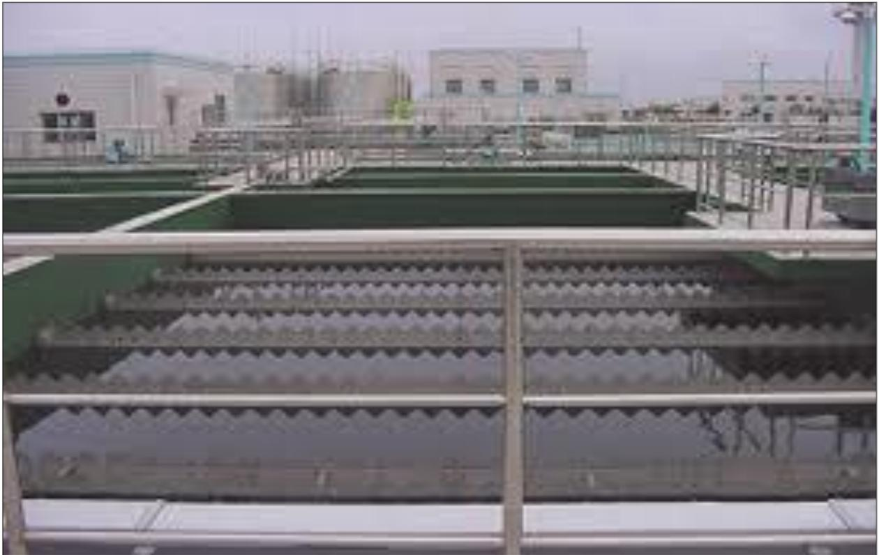
**Figure III.5 :** Décanteur rectangulaire
