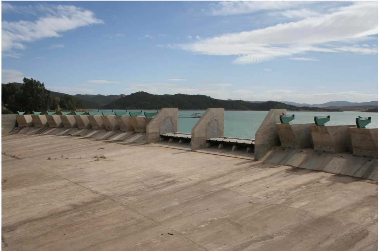
Figure V.2 : le barrage GRIB
