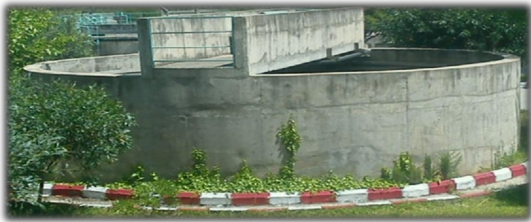
Figure II-10 : épaisseur des boues
