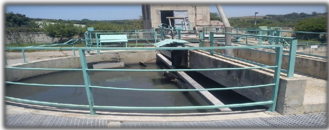
Figure II-6 : Désableur-dégraisseur
