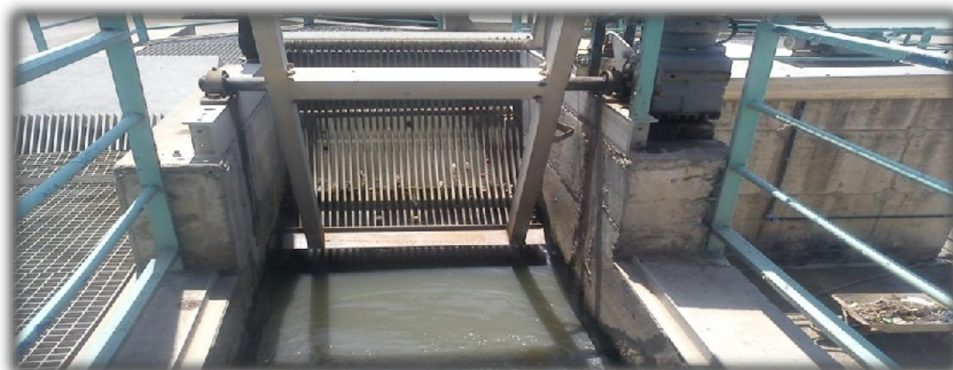
Figure II-5 : Dégrilleur
