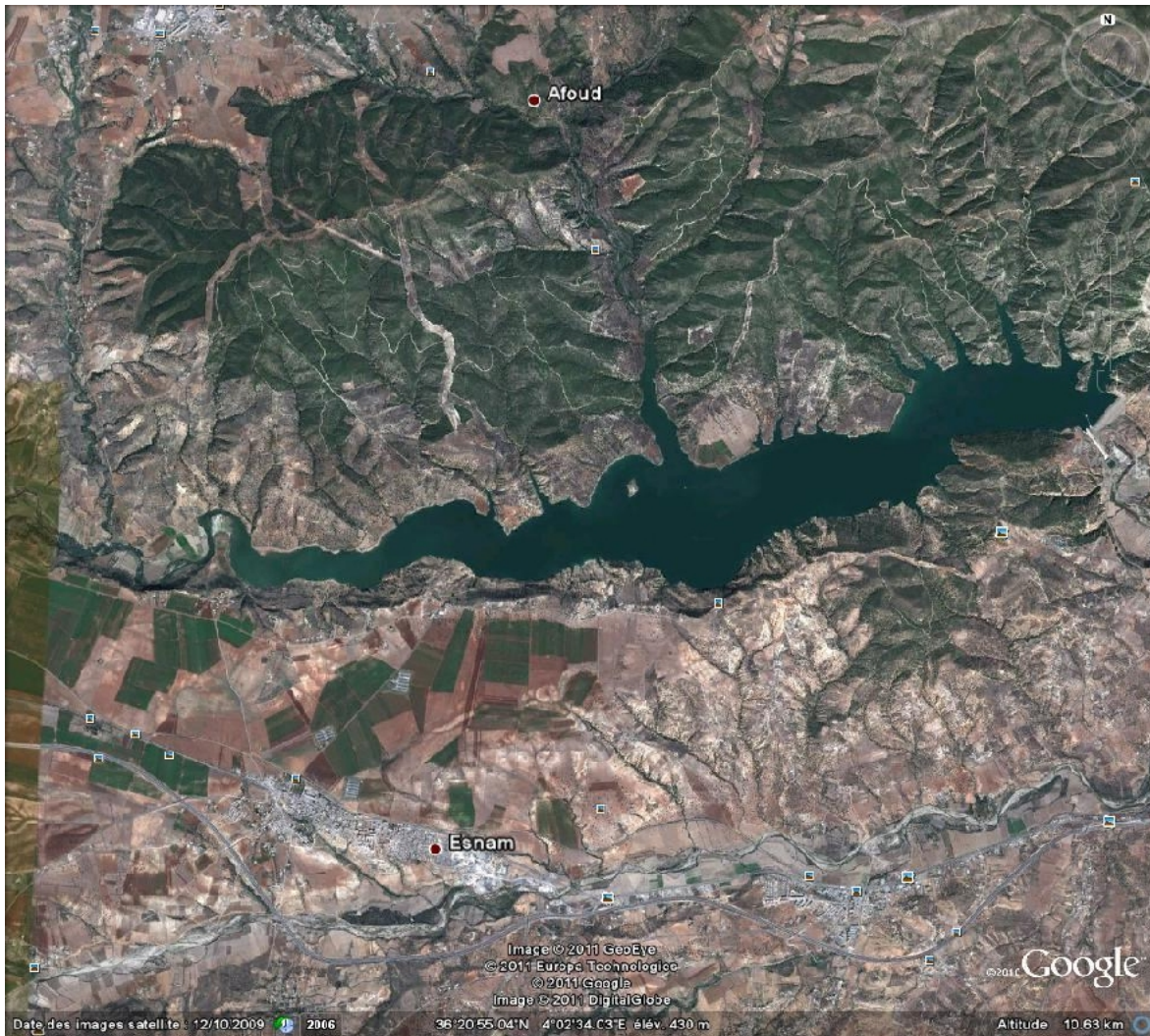
Figure III.1 : Situation géographique et coordonnées du barrage de TILESDIT
