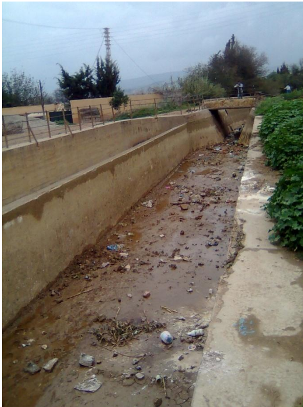
Figure 6 : Canal secondaire à l'intérieur d'une agglomération
