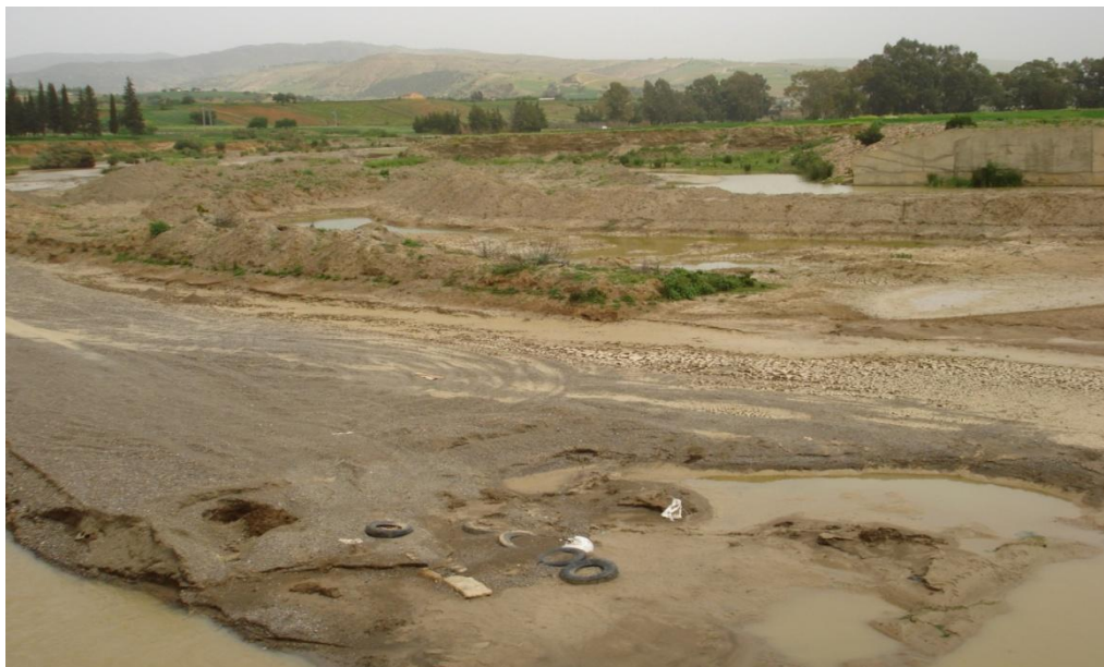
Figure 7 : Etat très avancé de l'envasement du barrage Fergoug.
