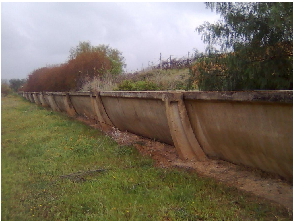
Figure 4 : Canal principal en excellent état
