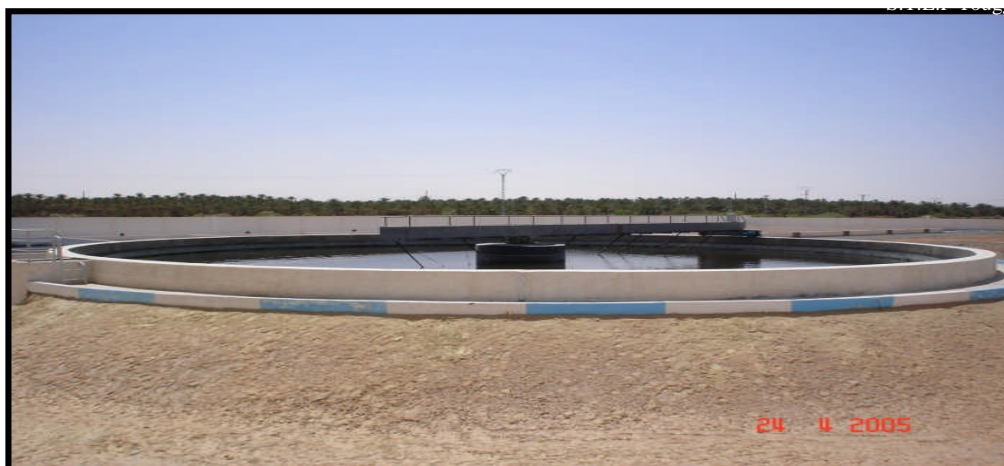
Figure IV-05: Décanteur
