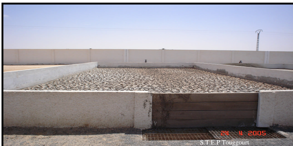
Figure IV-08: lit de séchage.
