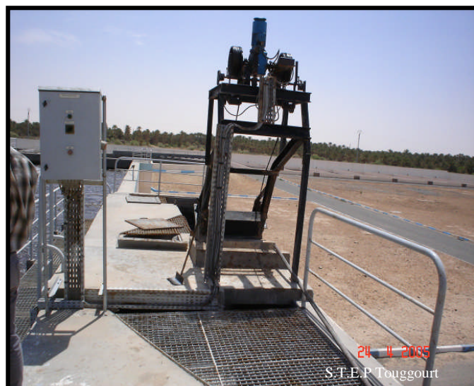
Figure IV-03: Dégrilleur mécanique
