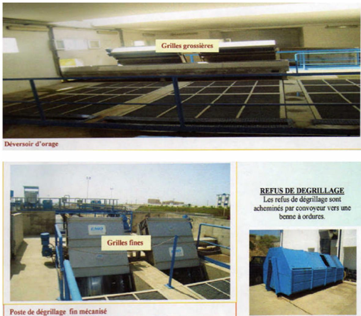
**FIGURE II.1 : DEVERSOIR DORAGE ET POSTE DE DEGRILLAGE FIN MECANISE**
