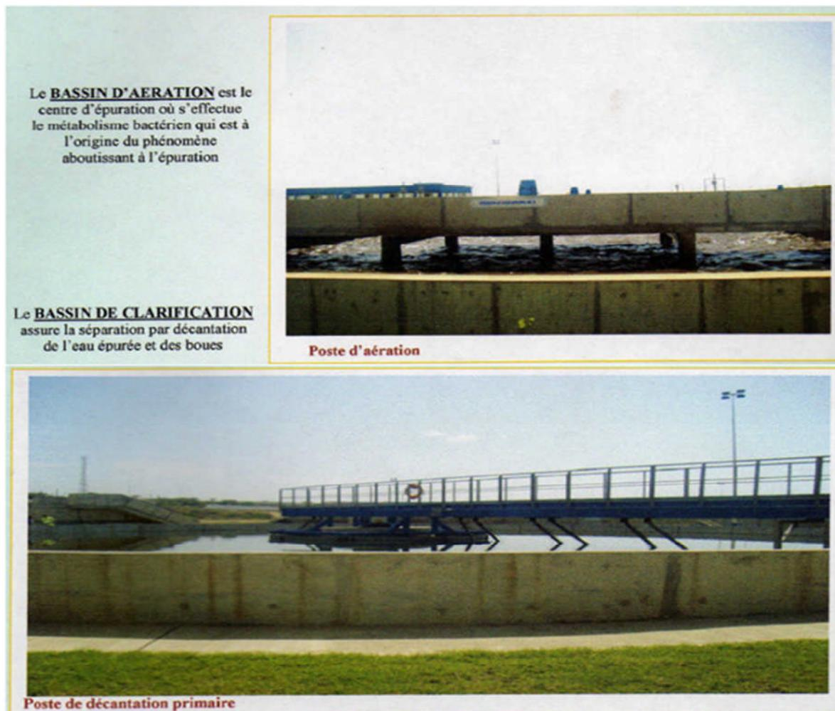
**Figure II.3** : poste d'aération et de décantation primaire
