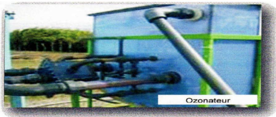
**Figure II. 12:** installation des équipements d'ozonation
